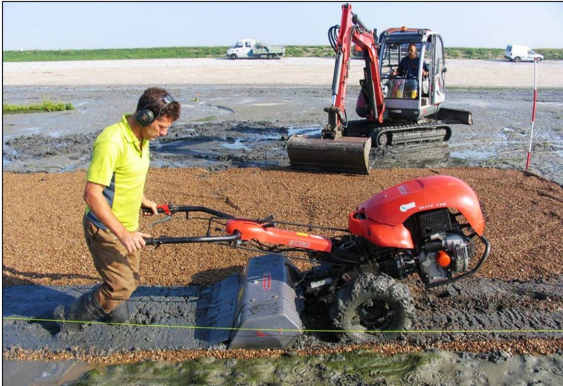
Foto 3 Aanbrengen schelpenlaag langs zeegrasveld op Dortsman Noord
