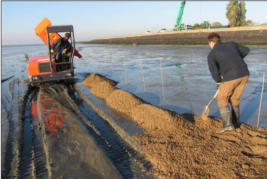
Foto 2 Aanbrengen schelpenlaag langs zeegrasveld parallel aan de dijk op Viane West
