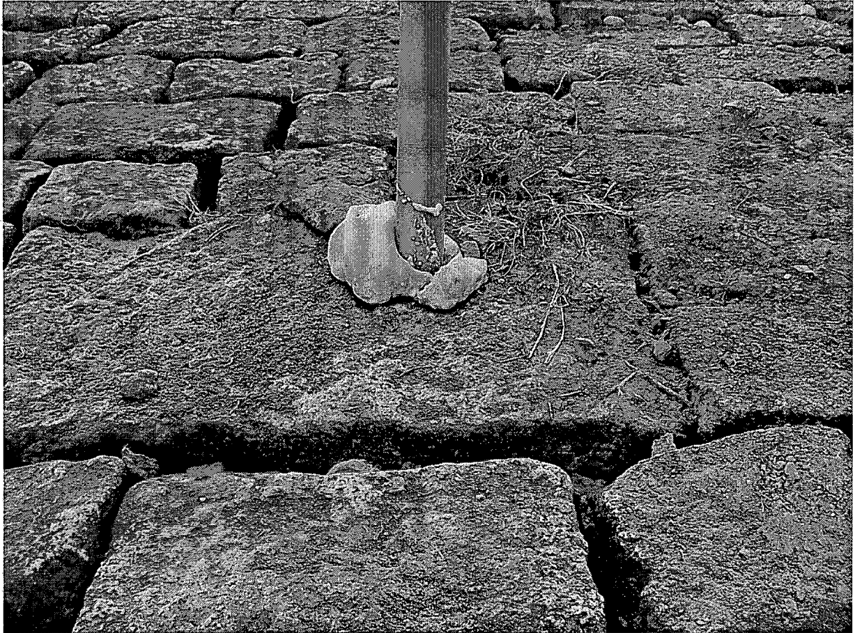
Foto 3: Afdichting met PUR-schuim
