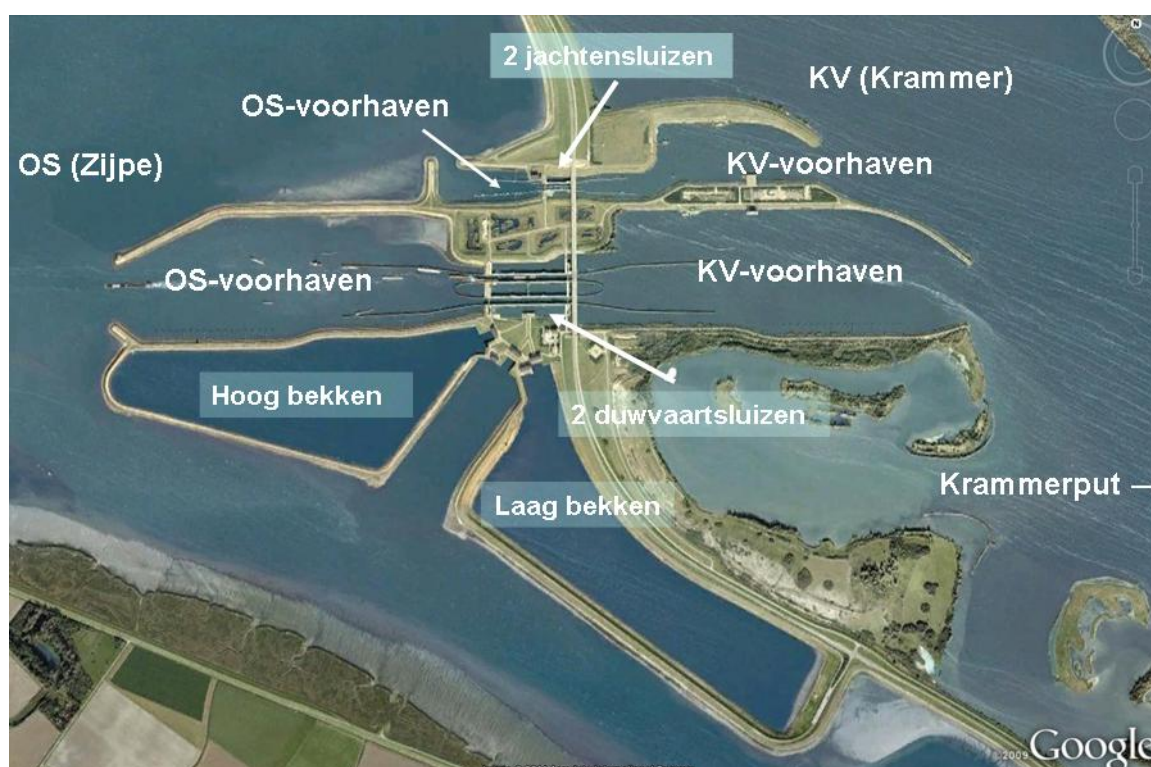
Figuur 2.1 Het Krammersluizencomplex in de Philipsdam (OS=Oosterschelde, KV=Krammer-Volkerak)
