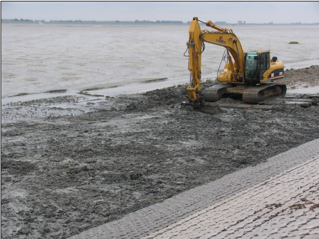
Foto 11a-b: Dijkwerkzaamheden op Viane Oost
