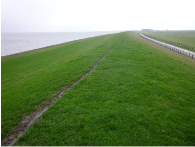
Figuur 3.9 Microreliëf op het dijktalud van de Waddenzeedijk door schapenpadjes (foto: J.M. van Loon-Steensma).
