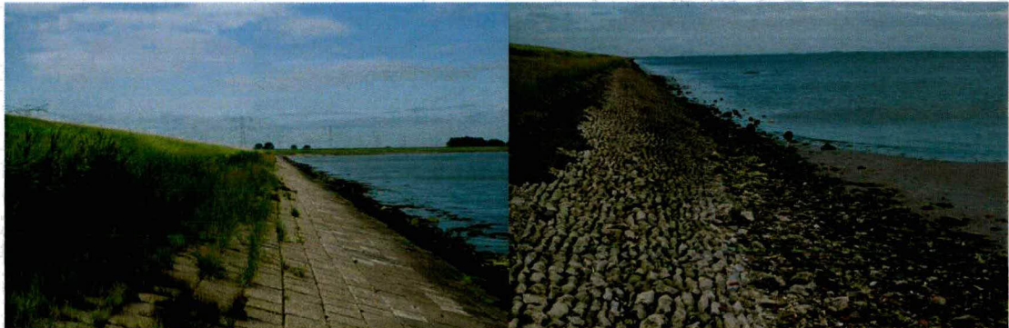
Foto 1.1: Dijktraject Karelpolder Nieuwlandepolder.
