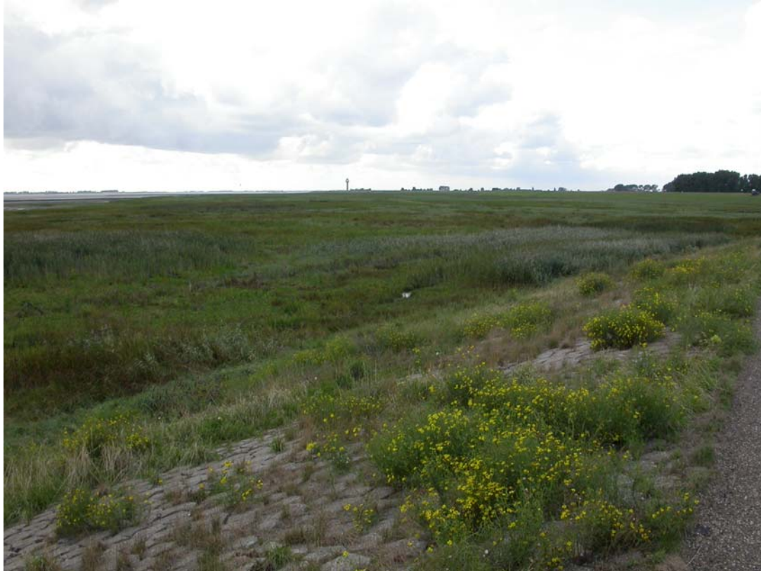
Zeedijk met betonzuilen en gevarieerde begroeiing, Zimmermanpolder, Westerschelde.
