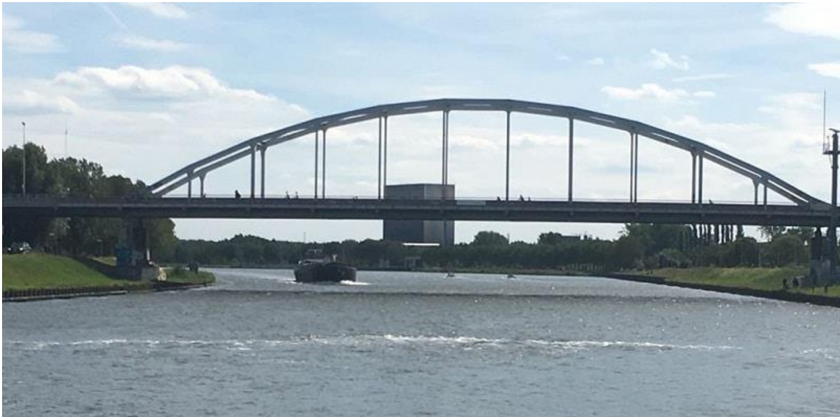
Afbeelding 9. Inzet tijdelijk bellenscherm in Amsterdam-Rijnkanaal (zomer 2018), dit is later vervangen door een permanente opstelling (bron: waterforum.net).
