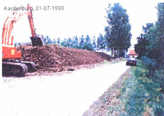
Foto 3.2. Verwerking toplaag in een wal.
