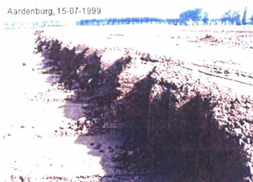
Foto 3.3. Selectief afgraven van de klei.
