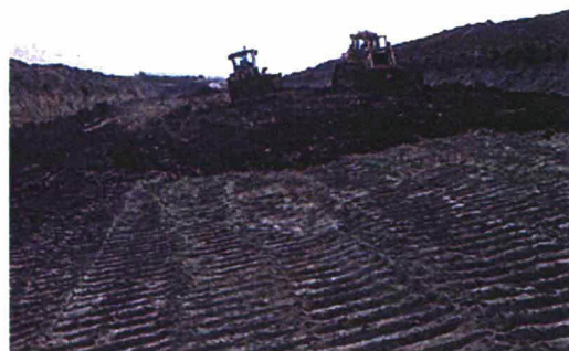
Foto 4.6. Aanbrengen 1 e kleilaag.
