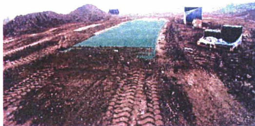
Foto 4.4. Aanbrengen kunststofgrasplaten.
