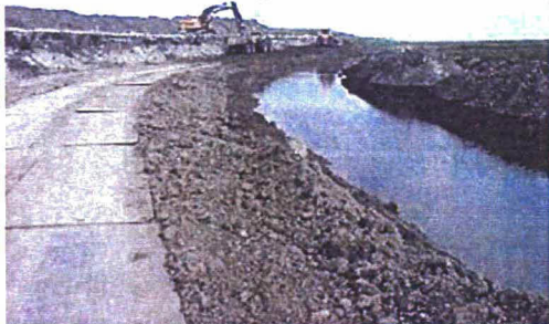
Foto 4.3. Aanvoerbaan met rijplaten.
