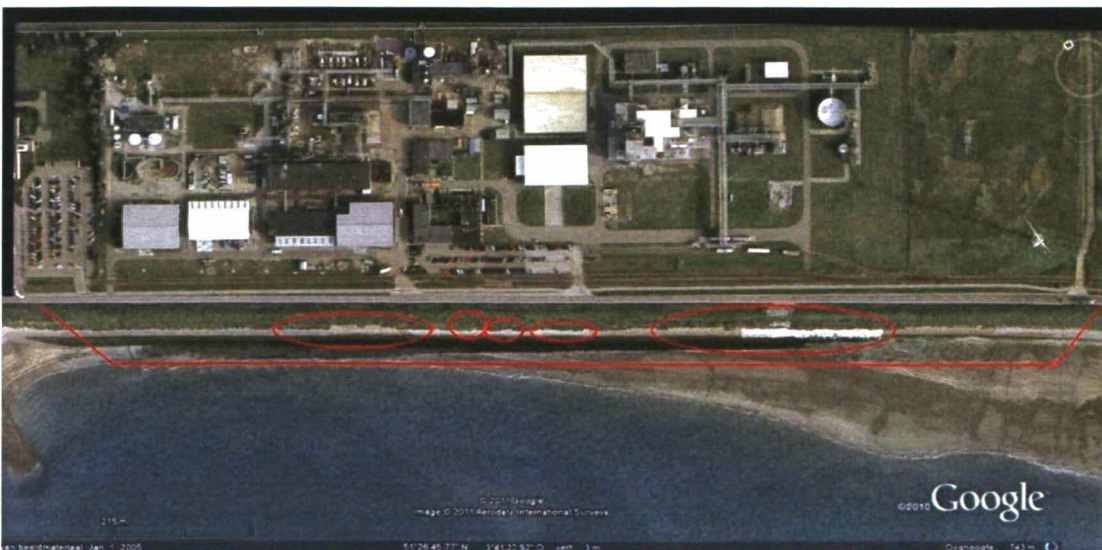
Dijkvak met verzwakte en te repareren gedeelte
