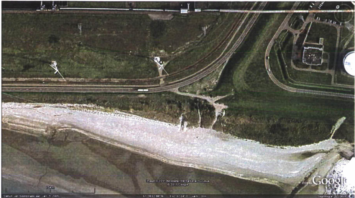
Gedeelte zeewering naar het westen, linkerzijde en het oostelijk duin midden en rechts huidige situatie.
