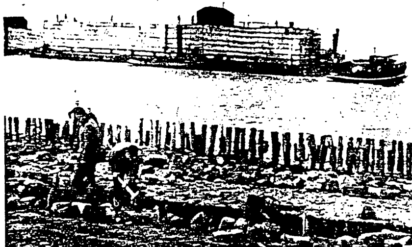
Fig. 13. Het plaatsen van een der phoenix caissons (BX 212) vóór de dijk, welke daar als golfbrekers hebben dienst gedaan ten tijde van de dichting der dijksbres.
