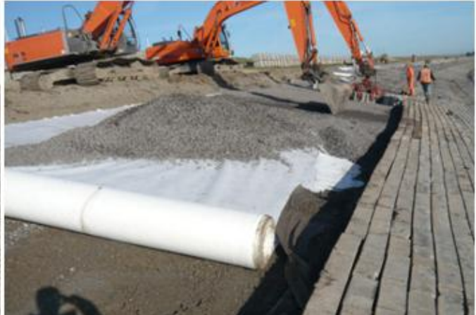
Figuur 2.4b: Uitvlakken tussenlaag met hydraulische kraan
