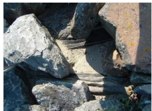
Figuur 2.6: Bezwijken van naainaden
