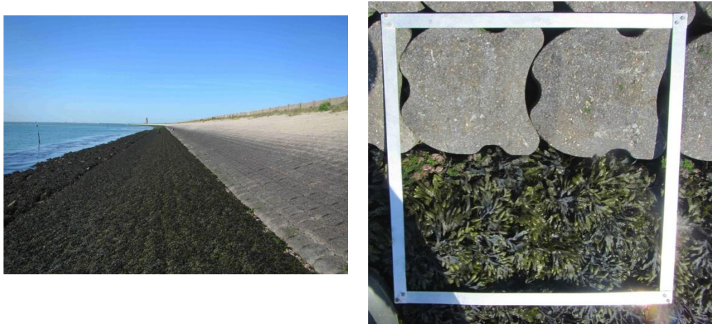
Afbeelding 5 Referentie Eco-toplaag van lava. Links: overzicht met Entophysalis en overgang naar diversie bruinwiegemeenschappen. Rechts: Scherpe overgang van Hydroblock naar Hydroblock met een eco-toplaag van lava.
