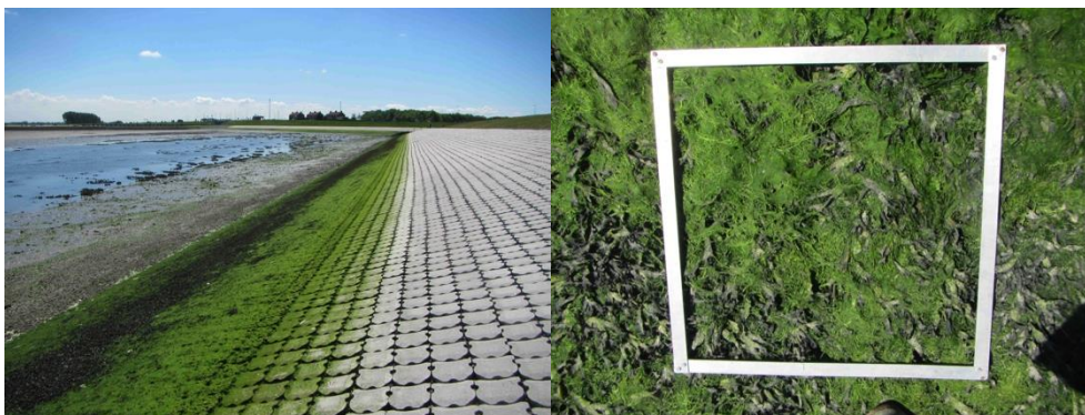
Afbeelding 6 Hydroblock met eco-toplaag van lava. Links: Zonering van darmwier en beginnende kleine-zee-eik levensgemeenschap. Rechts: opname met darmwier en kleine zee-eik.
