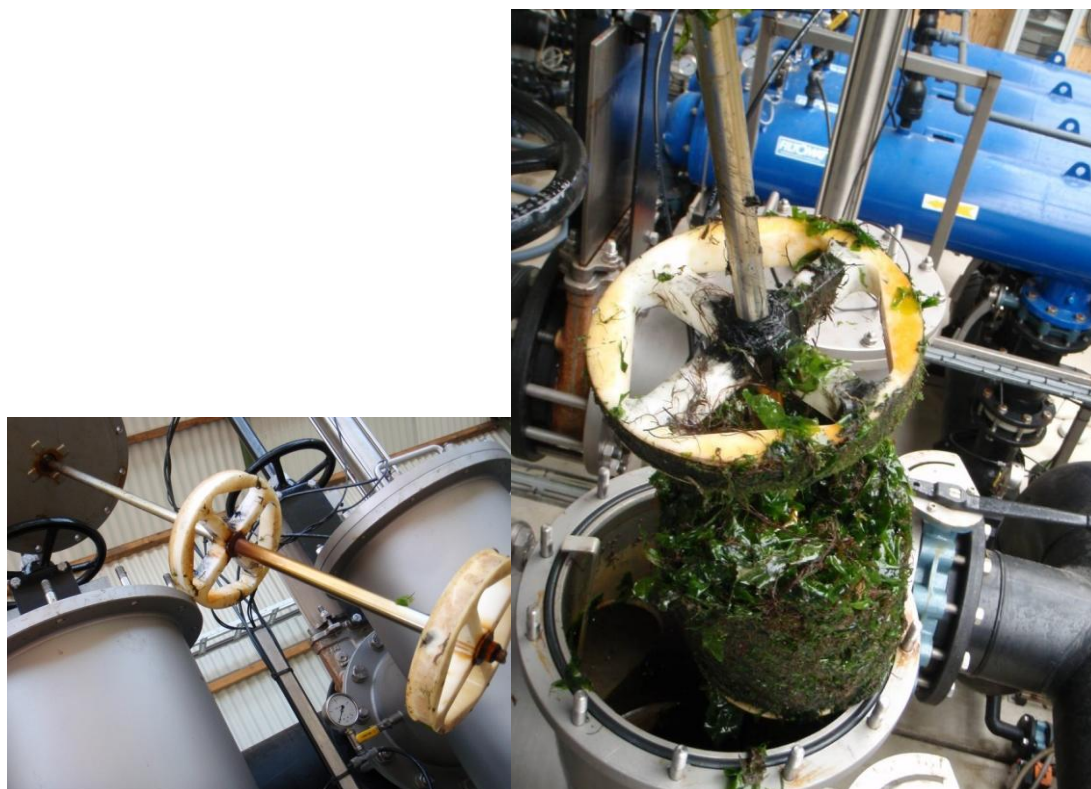
Figuur 7. Piston (li) van het grof filter. Ophoping van zeewier op en tussen de schrapers van de piston (re).
