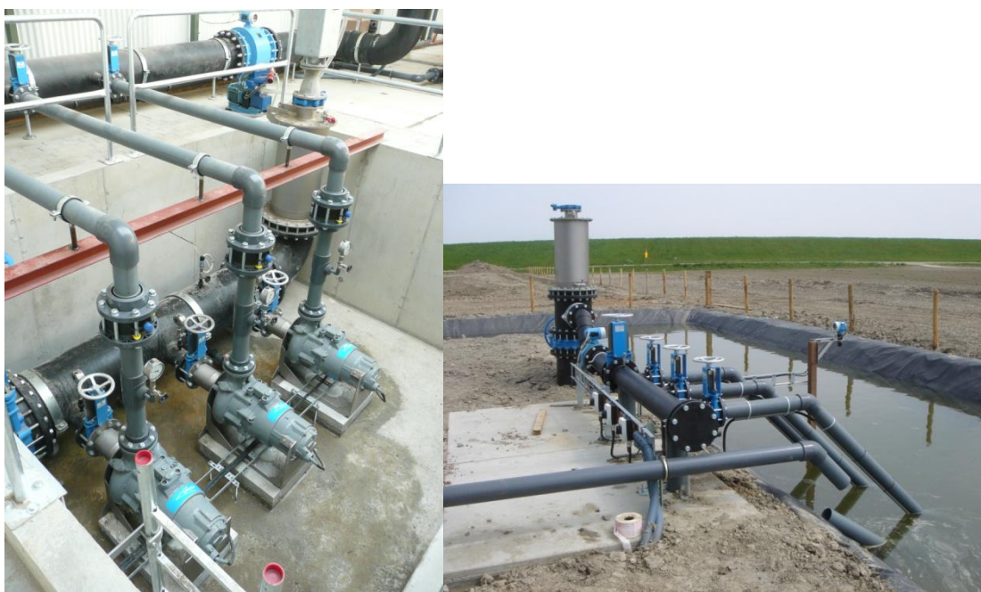
Figuur 4. Drie pompen geplaatst in een pompput in de loods zorgen voor de inname van water (li). Drie pompen geplaatst in een pompput in de ringsloot zorgen voor de lozing van water op de Oosterschelde (re).
