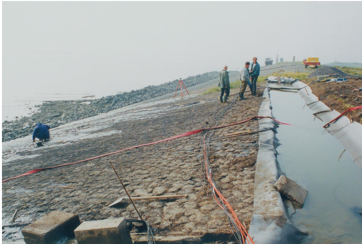
Figuur 7-5: Infiltratiemeting in Kruiningen
