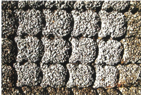
Figuur 13-4: Betonzuilen met ecotop
