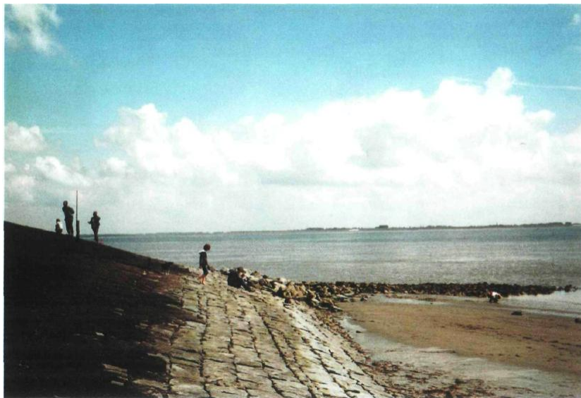
Figuur 12-4: Recreatie op het buitentalud
