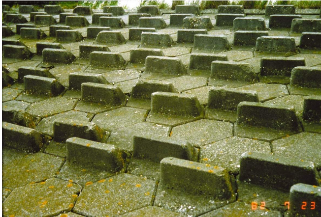
Figuur 4-1: Glooiing met ruwheidselementen13-12
