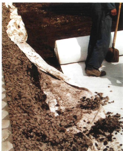
Figuur 13-14: Geokunststof op de rol tijdens aanbrengen
