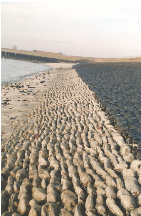
Figuur 12-3: Oude bekleding van Vilvoordse steen
