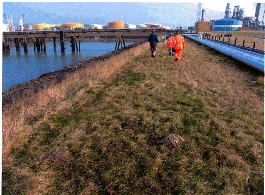
Berm met leidingenstraat
