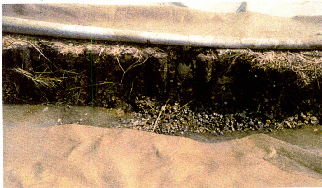
Detail van de granulaire laag ter plaatse van de infiltratiesloot na verwijderen van het geotextiel
