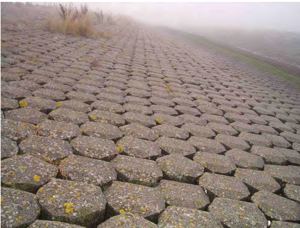
Betonzuilen. Nieuw Othenepolder, 4 november 2008 (Sietse Bouma; Bureau Waardenburg).
