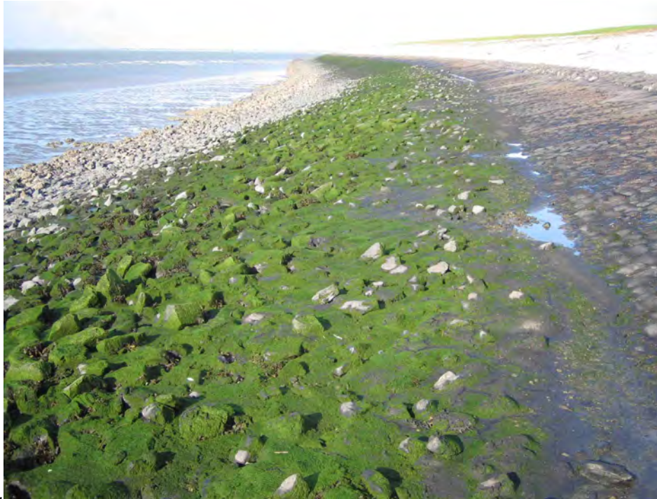
Breuksteen met gietasfalt, met "schone koppen". Kruiningenpolder, 2 oktober 2008 (Martien Meijer; Bureau Waardenburg).
