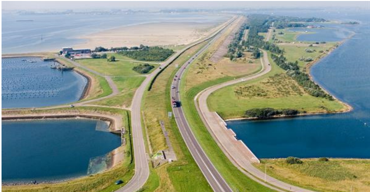
Afbeelding 2.1. De Flakkeese spuisluis, gelegen in de Grevelingendam (bron: https://beeldbank.rws.nl , Rijkswaterstaat / Joop van Houdt).
