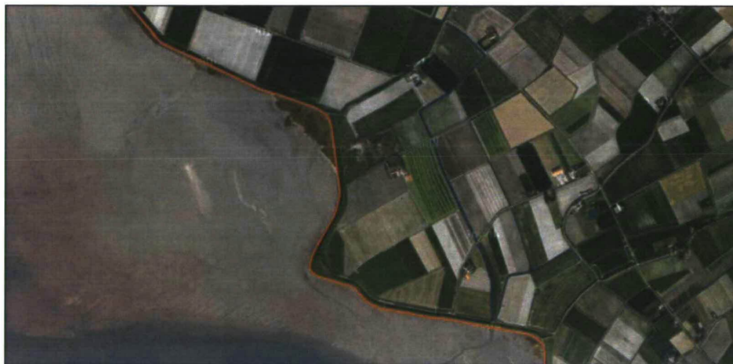
Afbeelding 7: Begrenzing van het Wetland Oosterschelde ter hoogte van dijktraject Stavenissepolder-Noordpolder.
