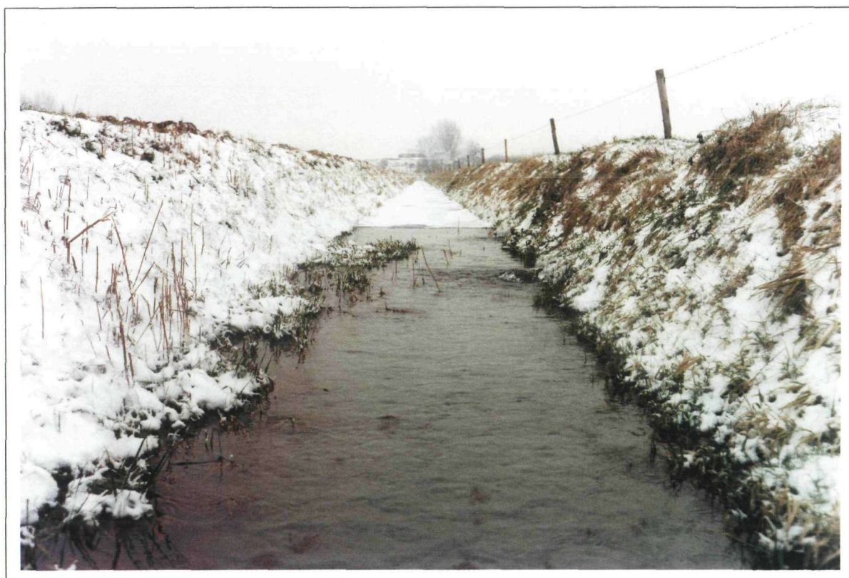
2.5: Stroming zichtbaar in de sloot aan de binnenteen van de Waaldijk te Herwijnen, tijdens vorstperiode. Plaatselijk is de sloot niet dichtgevroren. [RWS-DWW 199/24]
