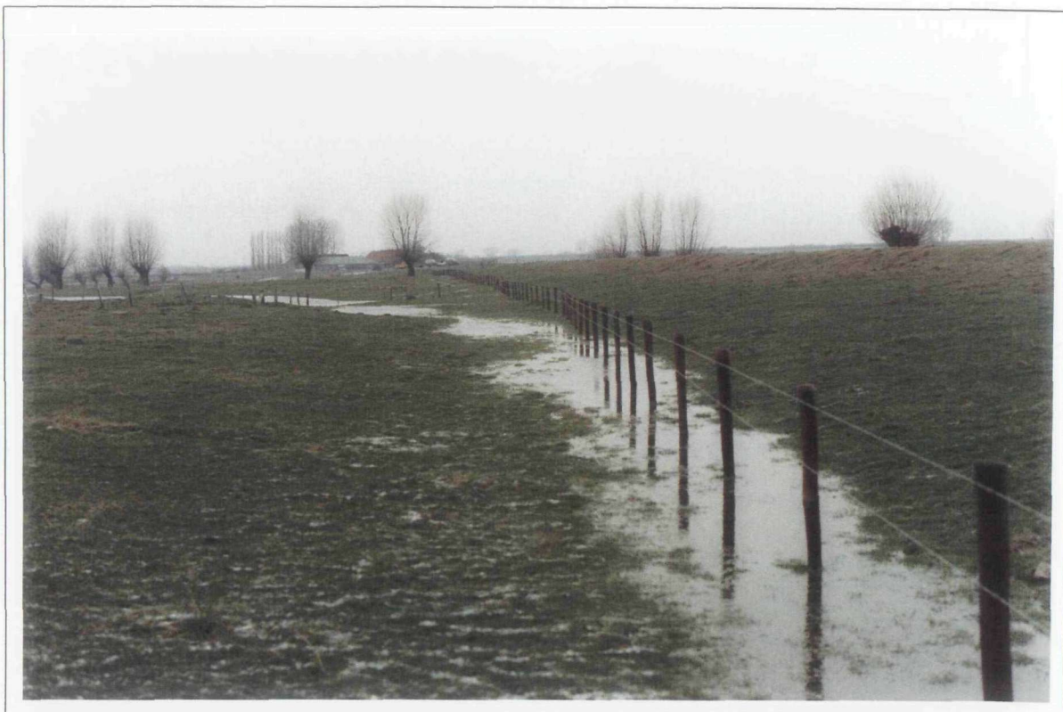
2.2: Kwel langs palenrij aan de teen van het binnentalud van de IJsseldijk te Wilp Is dit begin van piping, mede ten gevolge van de palenrij, of is dit oppervlaktewater dat zich verzamelt op een laagste punt? [RWS-DWW 197/23a]
