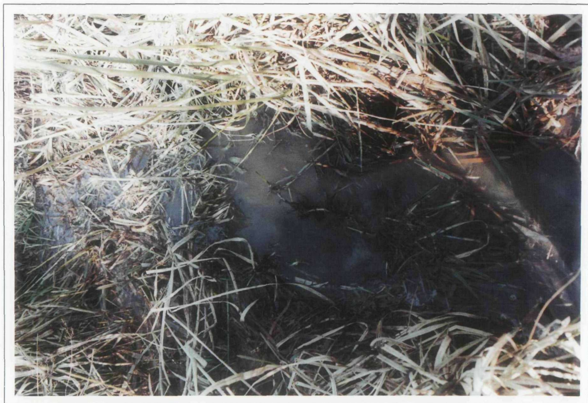
2.7: Wel uit de slootkant langs de teen van de Waalbandijk (hmp 348); er wordt nog geen zand meegevoerd. [RWS-DWW 132/9a]
