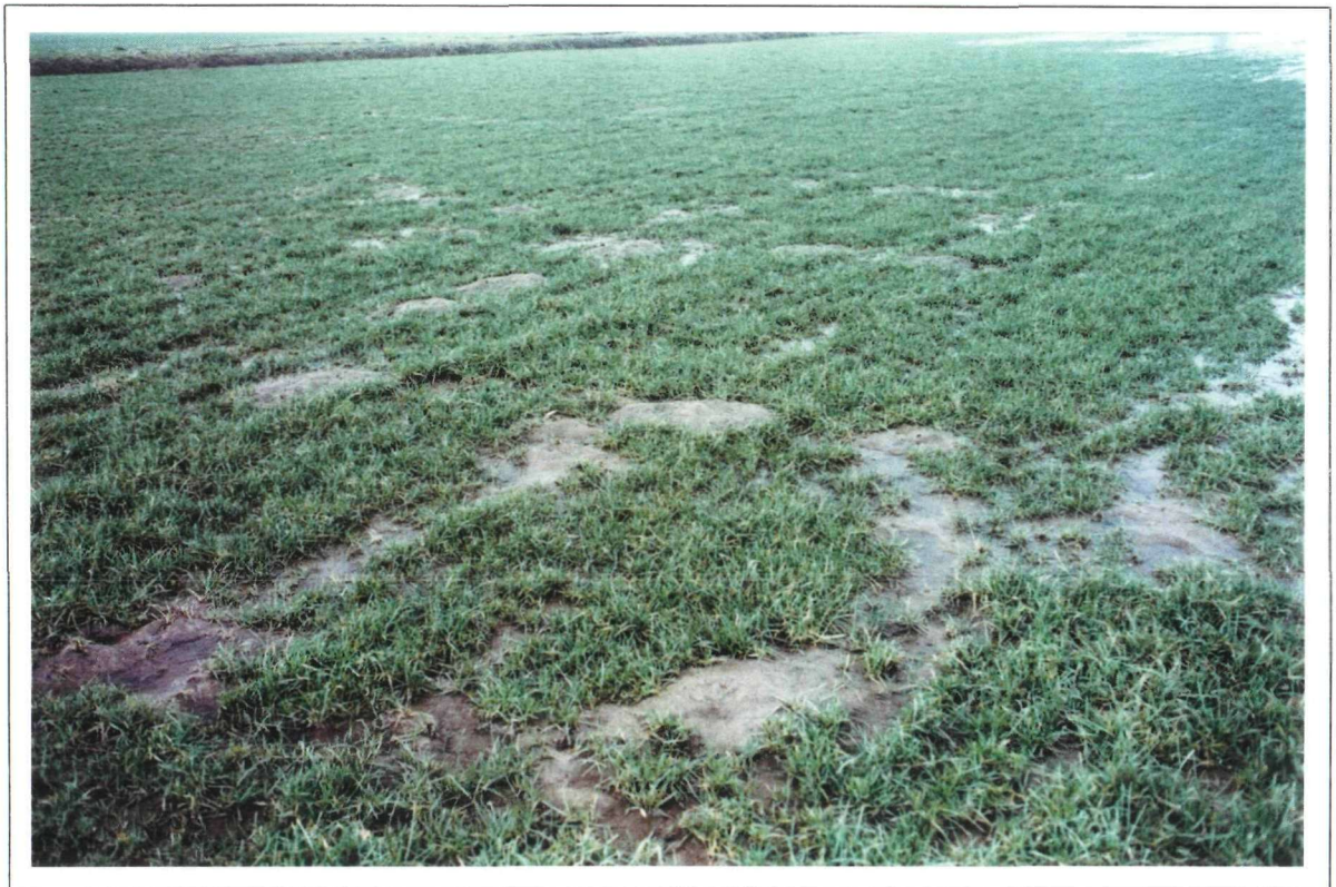
2.13c: Zandmeevoerende wellen op het maaiveld achter de dijk, mogelijk door mollengangen. [RWS-DWW 130/11]
