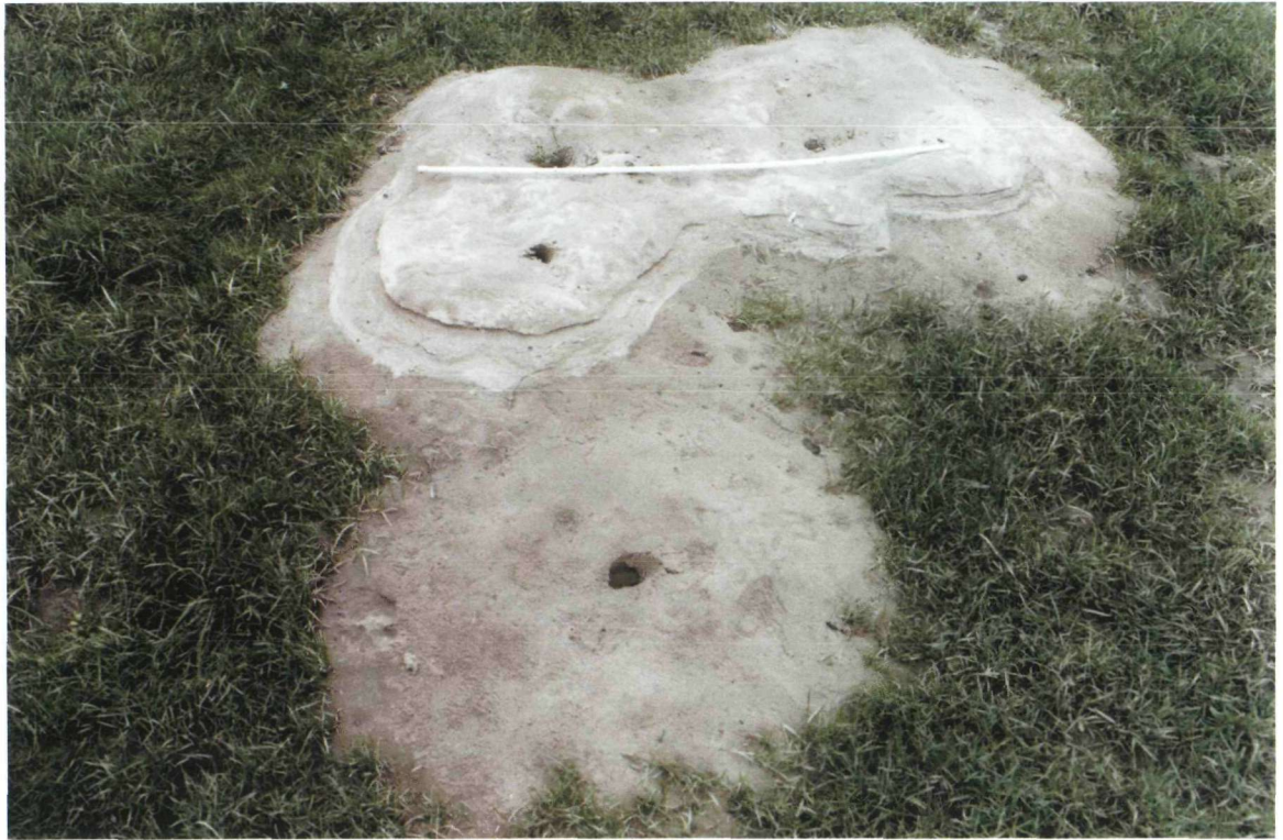
1.2 b: Droge wellen op de Hondsbroekse Plei (IJsselkop). Mogelijke aanleiding: mollandengangen. Van belang is de aan de inspectie voorafgaande hoogwaterstand. [RWS-DWW 133/4]
