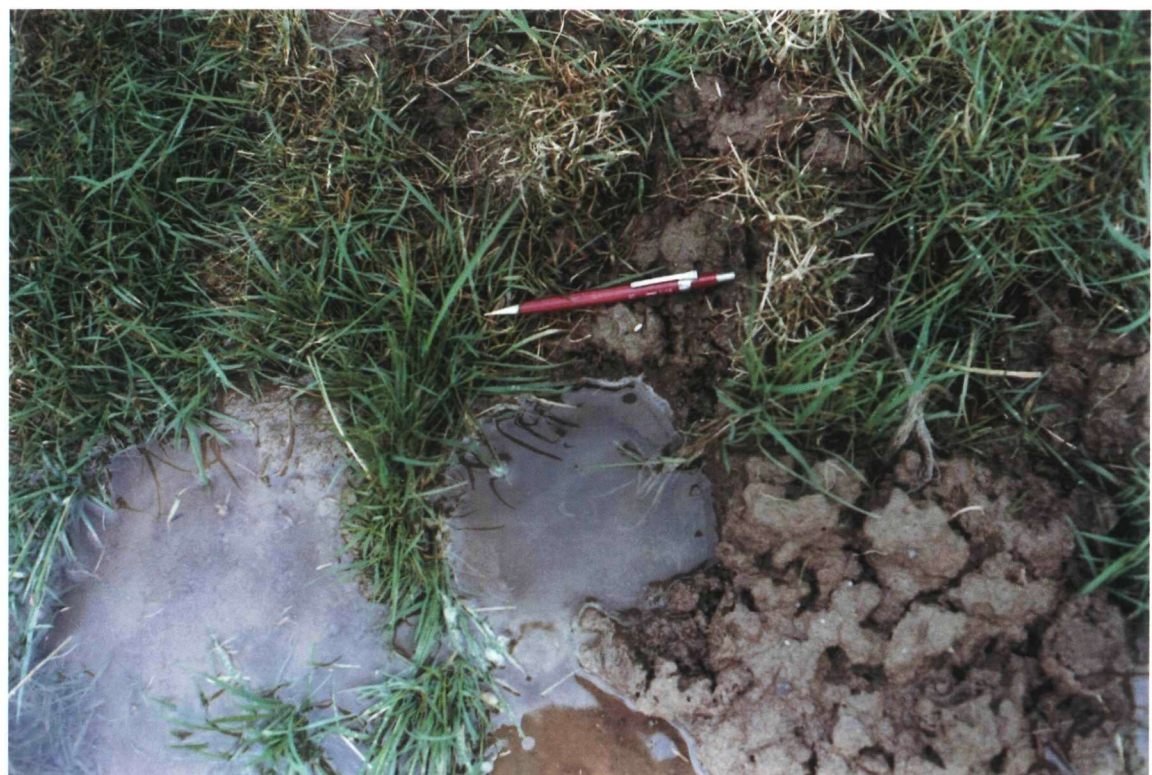
1.2a: Molshopen linker IJsseldijk te Wilp: is dit verzameld regenwater of al een teken van kwel? Van belang bij de beoordeling is de actuele weersgesteldheid en buitenwaterstand. [RWS/DWW 165/18a]
