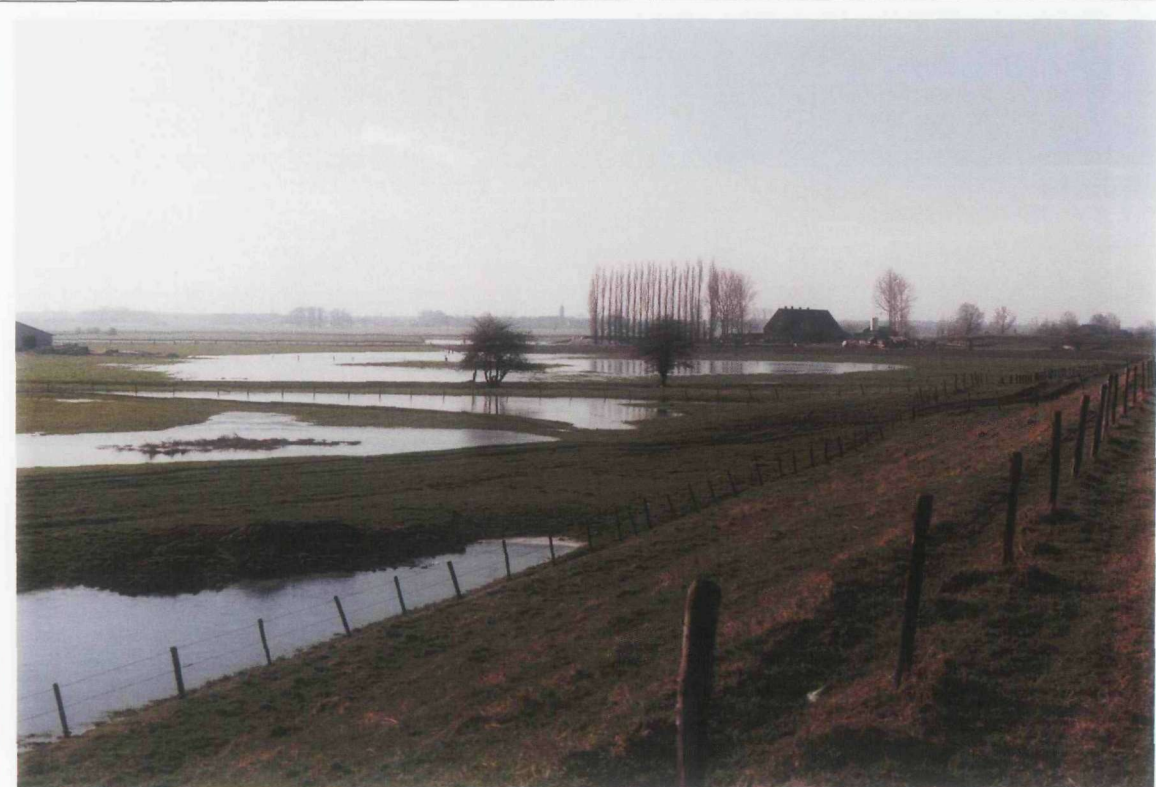
1.3b: Kleiafgraving direct aan binnendijk (Maasdijk te Velp, Noord-Brabant). Ter plaatse van de afgraving is verhoogde waakzaamheid geboden: piping kan hier pas in relatief vergevorderd stadium worden opgemerkt. [RWS-DWW 322/18]
