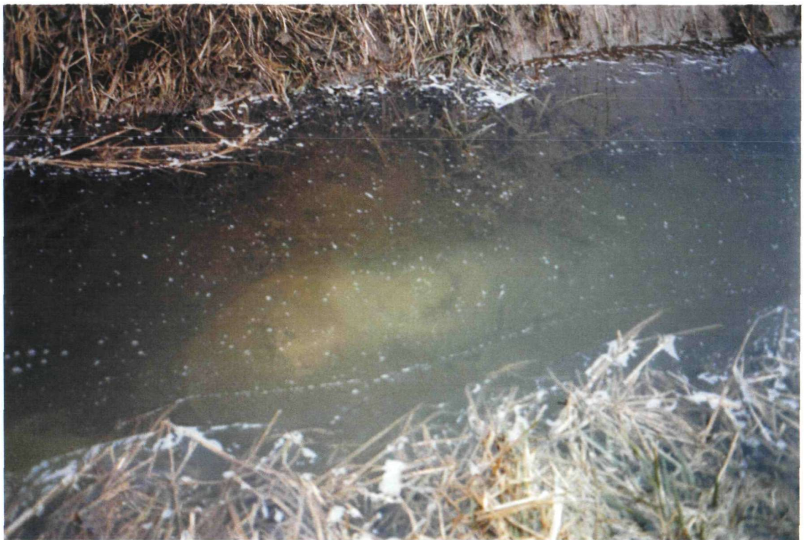
2.12c Zand in slootwater; beginnende zandmeevoerende wel ter plaatse van de bodem van een kwelsloot [RWS-DWW 127/12]
