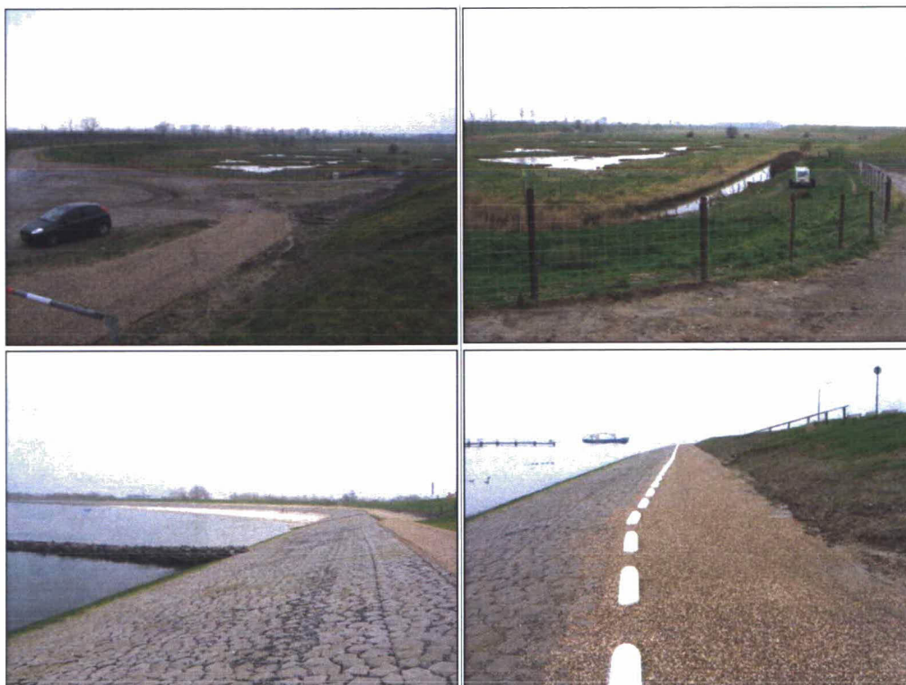
Figuur 2: links- en rechtsboven: oplevering van depotlocatie bij Koude- Kaarspolder en nieuwe raster. Links- en rechtsonder: oplevering dijktraject ter hoogte van strand en Koningin Julianahaven.
