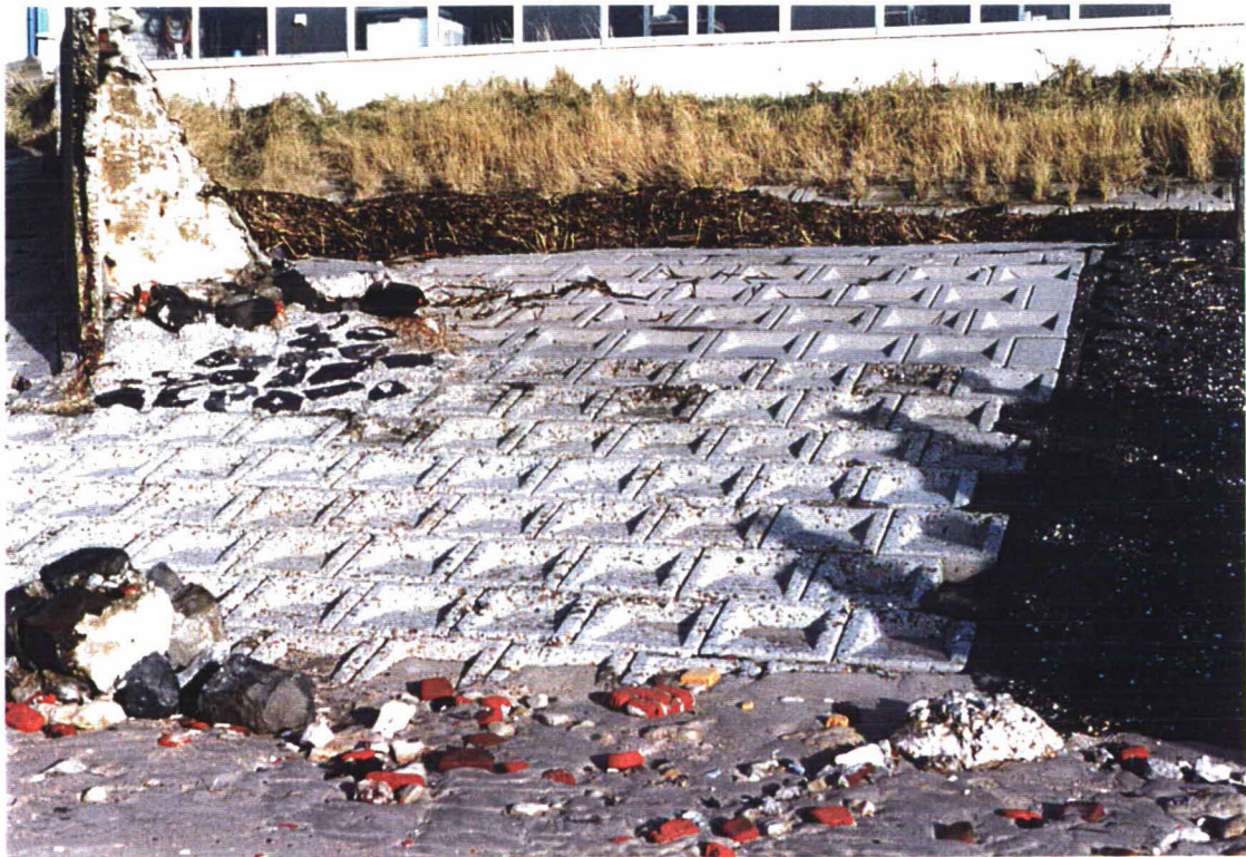
Foto 8 Aan de westelijke begrenzing van het bekledingsvak (het muurtje) grenst nog een klein stuk dat eventueel meegenomen zou kunnen worden in de renovatie van de Haringmanblokken
