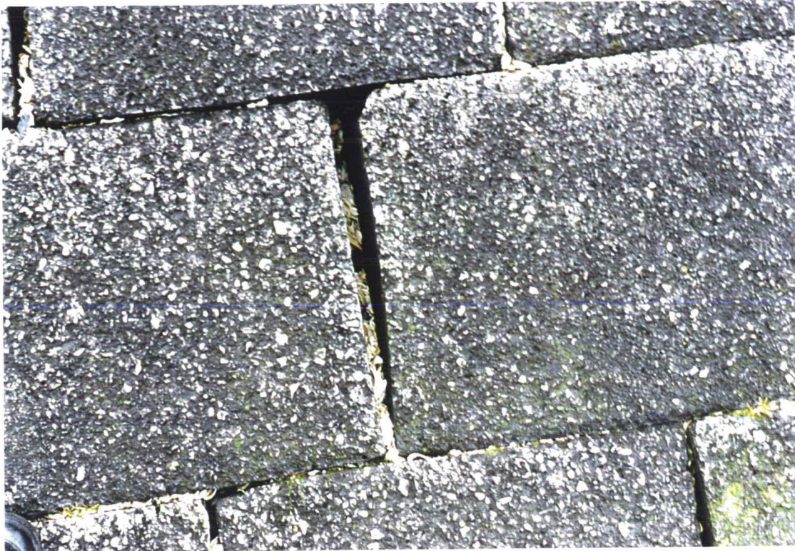
Foto 3 De spleten tussen de koperslakblokken zijn afwisselend ruim en nauw. Tussen de spleten zitten schelpen.
