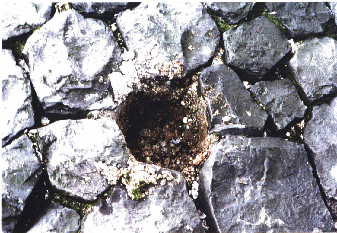
Foto 12 Gat in de basalt hoog op het talud bij dp 93. Er is duidelijk sprake van inzanding.
