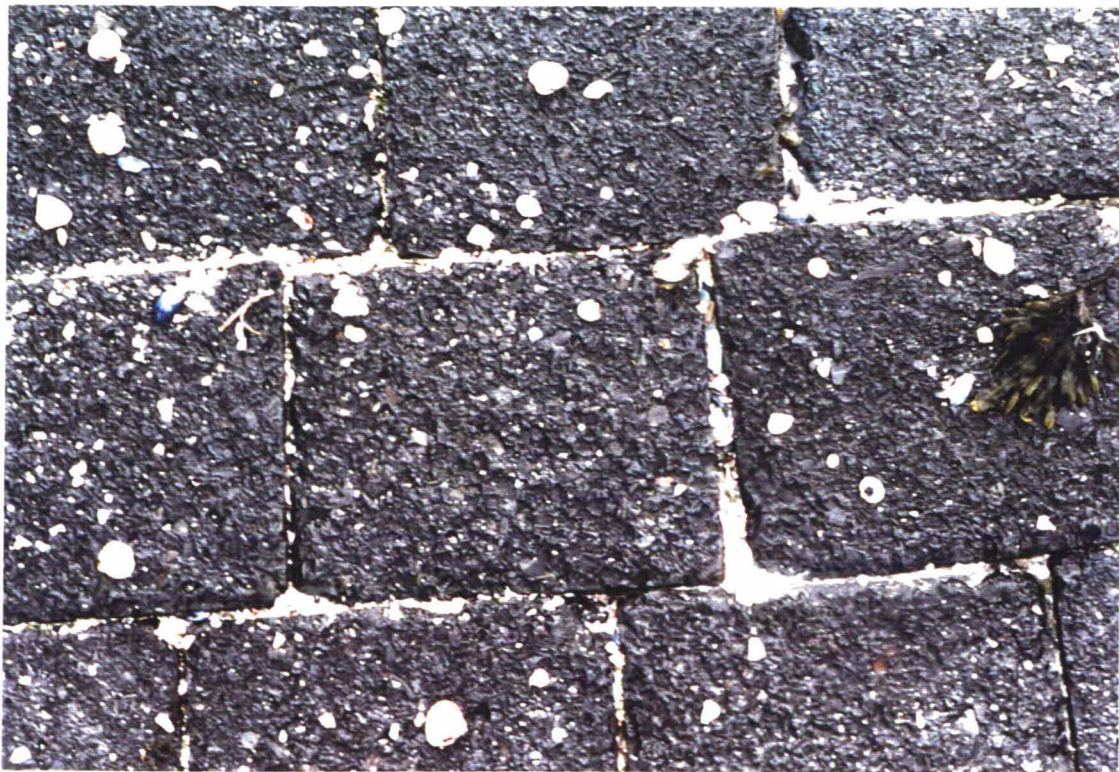
Foto 6 De koperslabblokken laag op het talud zijn kleiner van formaat. De spleten zijn smal en volledig gevuld met schelpgruis.
