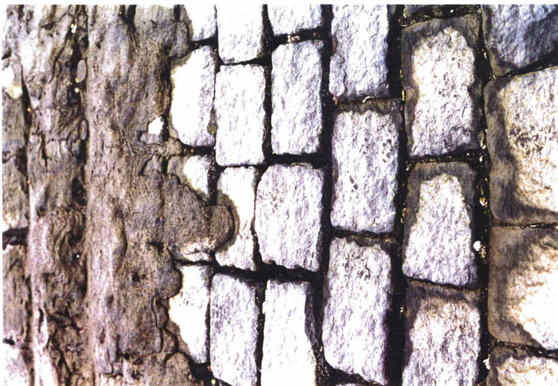
Foto 2 Graniet met daarboven overgoten Doornikse steen
