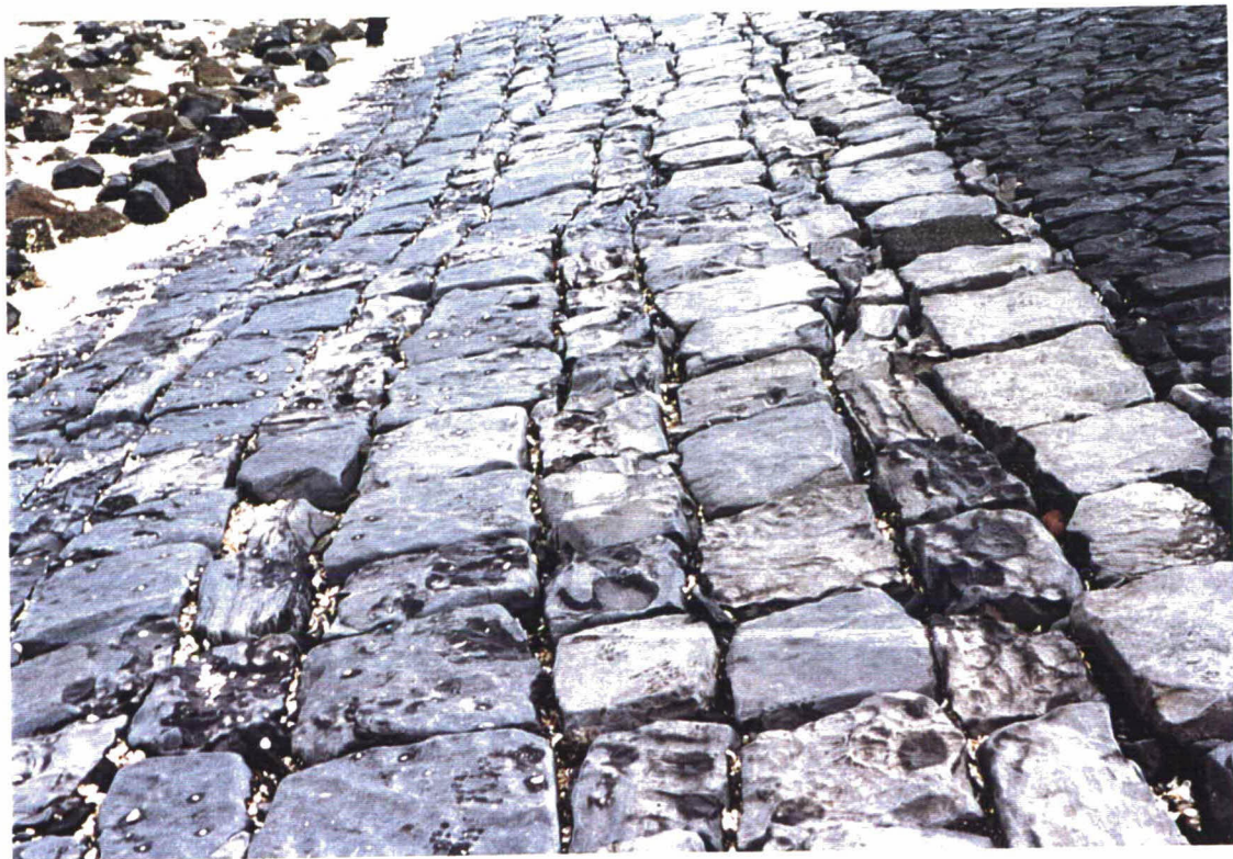
Foto 16 Indruk van de bekleding van Doornikse blokken bij dp 87. De blokken zijn om en om plat en op zijn kant gezet.
