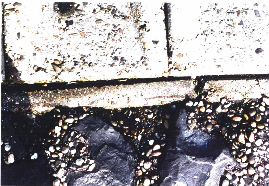
Foto 4: Overgangsconstructie van gepenetreerde basalt naar Haringmanblokken
