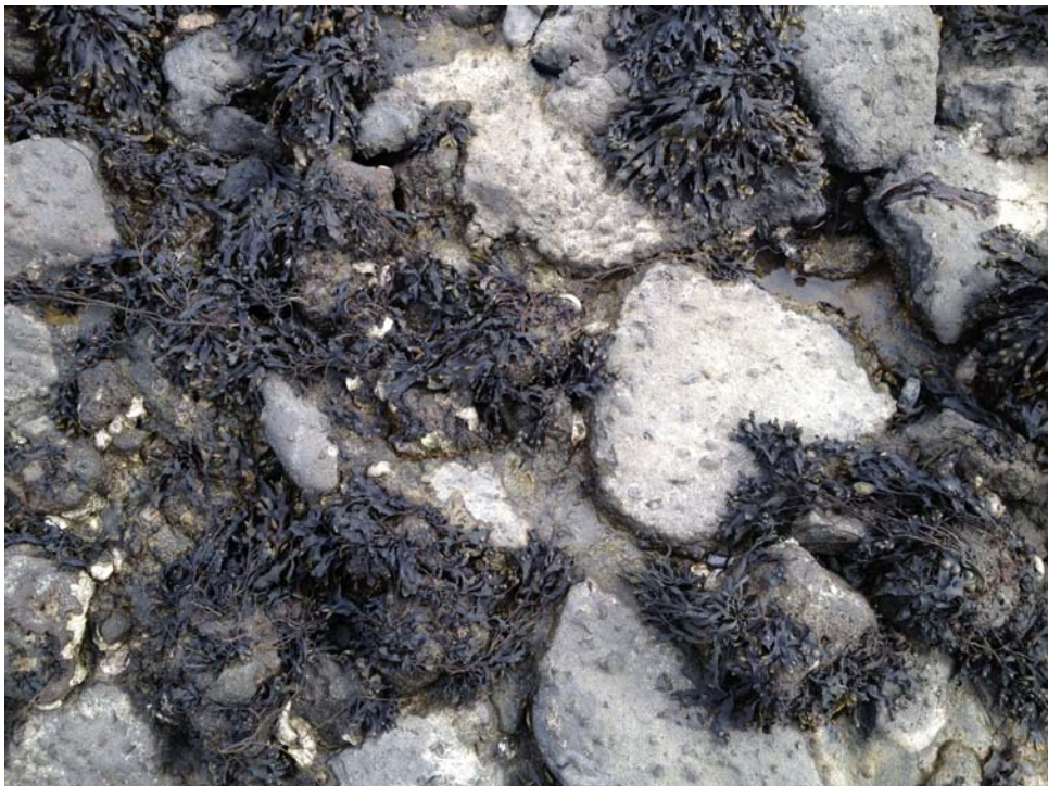
Foto 2.4. Blaaswier vastgehecht op lavasteen. De open vlakken zijn merendeels gietasfalt.
