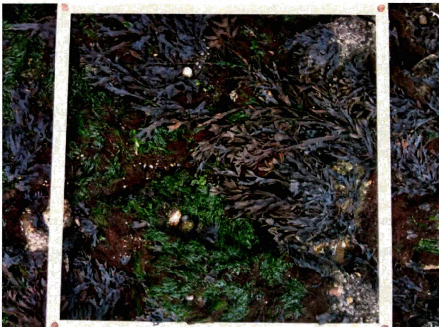
Breksteen met gietasfalt, met "schone koppen". De bruinwieren zijn vastgehecht op stenen, groenwieren op gietasfalt. Nabij Zeelandbrug (Oosterschelde), 5 augustus 2010 (Martien Meijer; Bureau Waardenburg).
