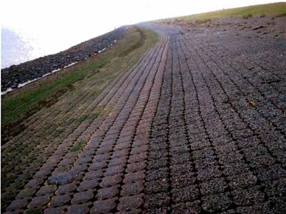
Hydroblocks: links zonder, rechts met eco-toplaag. Ellewoutsdijkpolder, 19 november 2008 (Martien Meijer; Bureau Waardenburg).
