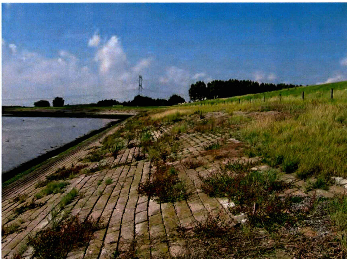
Zonering op een dijk: boven gemiddeld hoog water een ijle zone met zoutplanten en bovenaan een dichte vegetatie van planten die minder zouttolerant zijn. Gekantelde betonblokken (Biezelingsche Ham, 11 september 2008 (Roy van Grunsven; Bureau Waardenburg).
