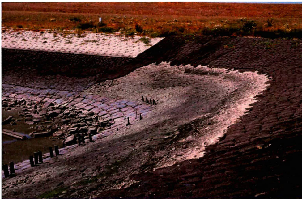
In 1990 waren dergelijke lappendekens aan steensoorten aanwezig. Omgeving Bakendorp, 13 augustus 1990 (Martien Meijer; Bureau Waardenburg).
