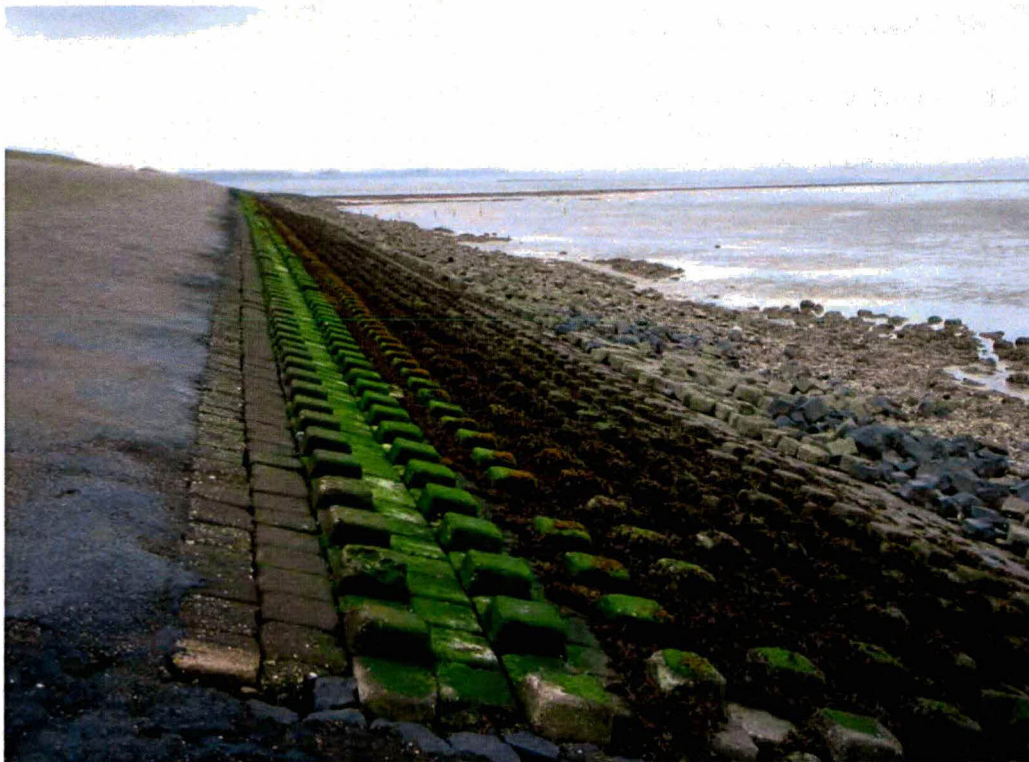
Zonering van verschillende wiergemeenschappen op een glooiing met diaboolblokken, daarboven onbegroeid asfalt. Ser Arendspolder, 18 oktober 2008 (Wouter Lengkeek; Bureau Waardenburg).
