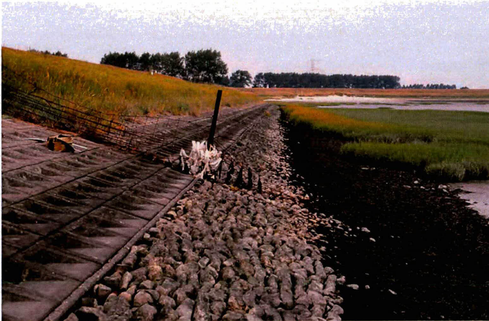
Oude glooiing van haringmanblokken en kalksteen, onderaan begroeid met Knotswier. Nabij Hoedekenskerke, 10 augustus 1990 (Martien Meijer; Bureau Waardenburg).
