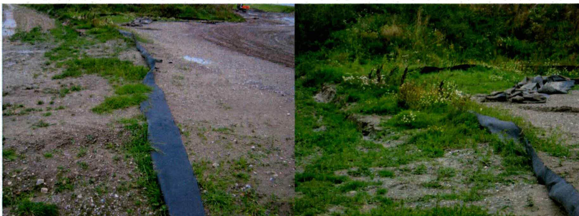
Paddenschermen in het depot aan de Del Campoweg. De linkerfoto laat zien dat het scherm plat ligt en de rechterfoto laat overhangende vegetatie zien.
