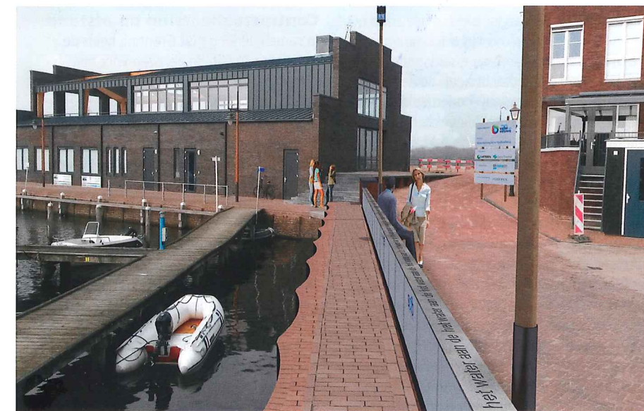
Bij hoogwater stroomt de kering vol en komt automatisch omhoog.
