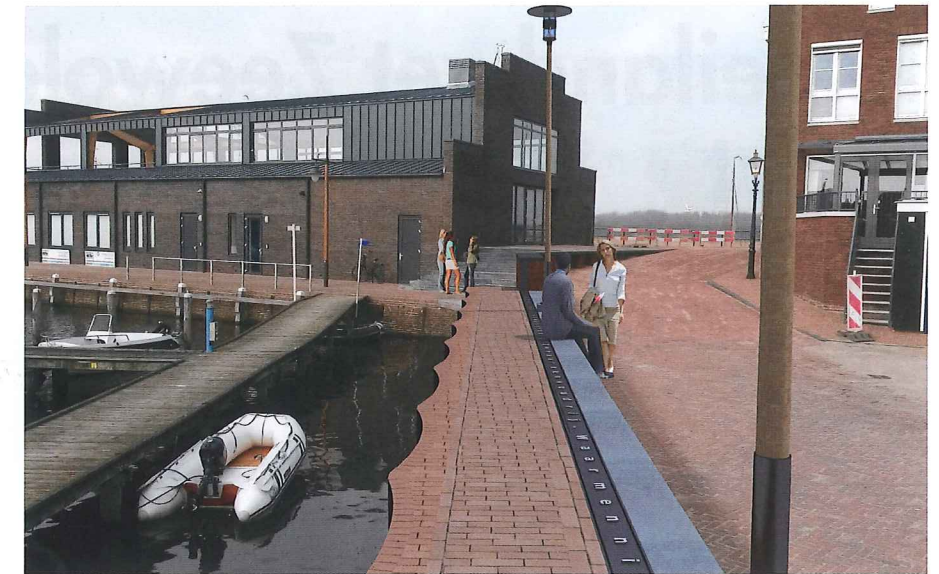
Als de kering niet nodig is, rust zij in de grond.
