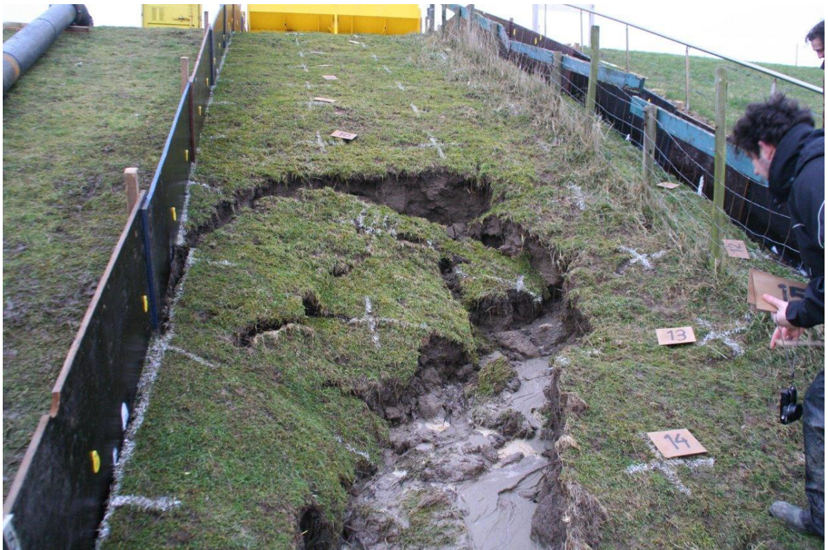
Figuur B91. Tholen. Sectie 3, afrastering. Bezweken talud.
