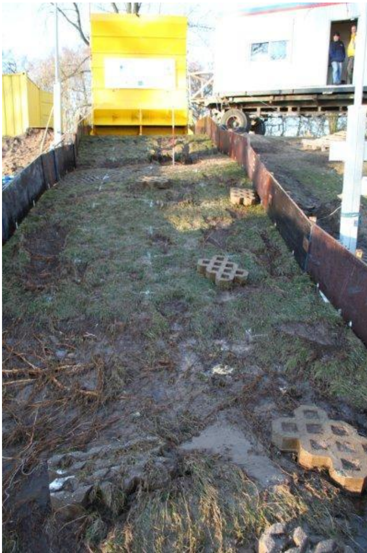
Foto B39. Vechtdijk. Zeeregime met dijkovergang, proef 1; Talud na de proef niet bezweken.
