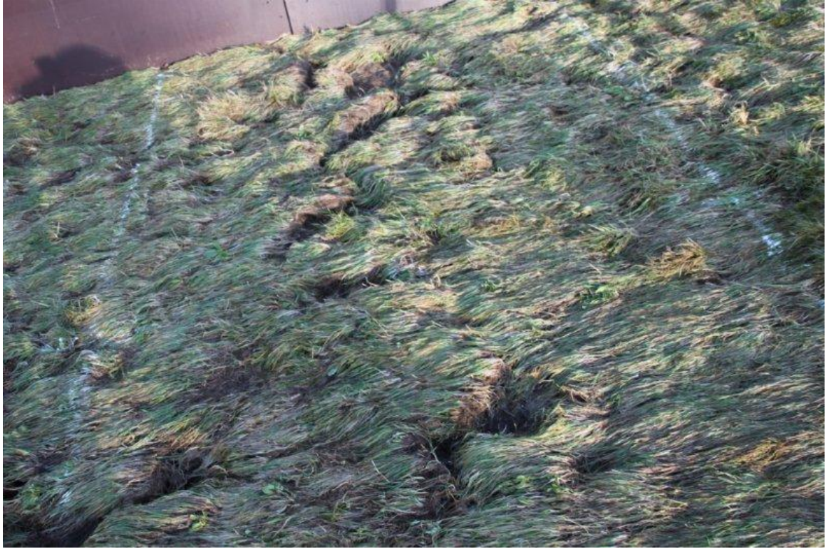
Foto B64. Vechtdijk. Hydraulische metingen; Na de metingen.
