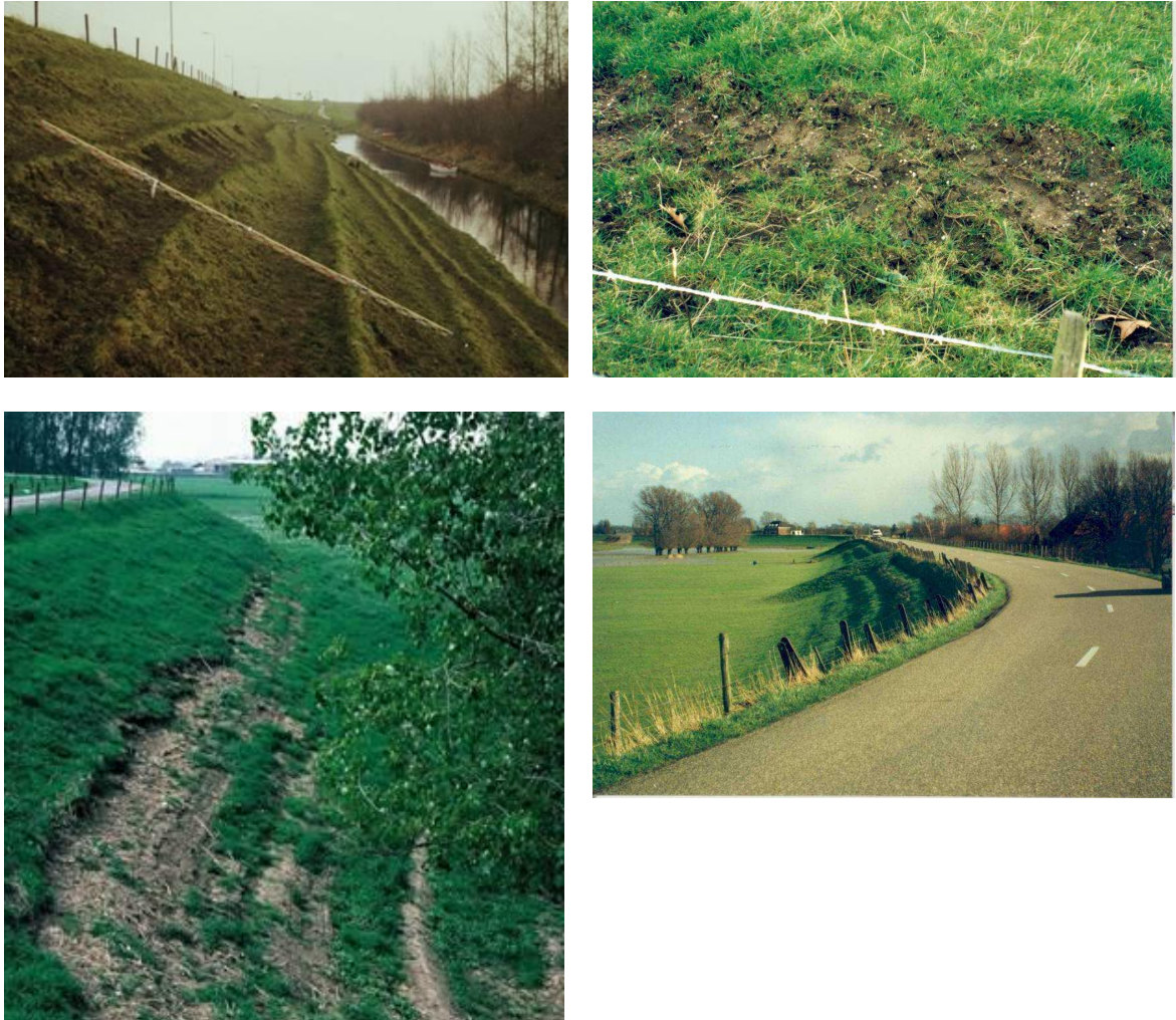
Figuur 3.5 Microreliëf door schapenpaadjes (boven), eerdere schade buitentalud bij golfaanval (linksonder), door methode van aanleg (rechtsonder). Bron: Beeldenbank RWS
