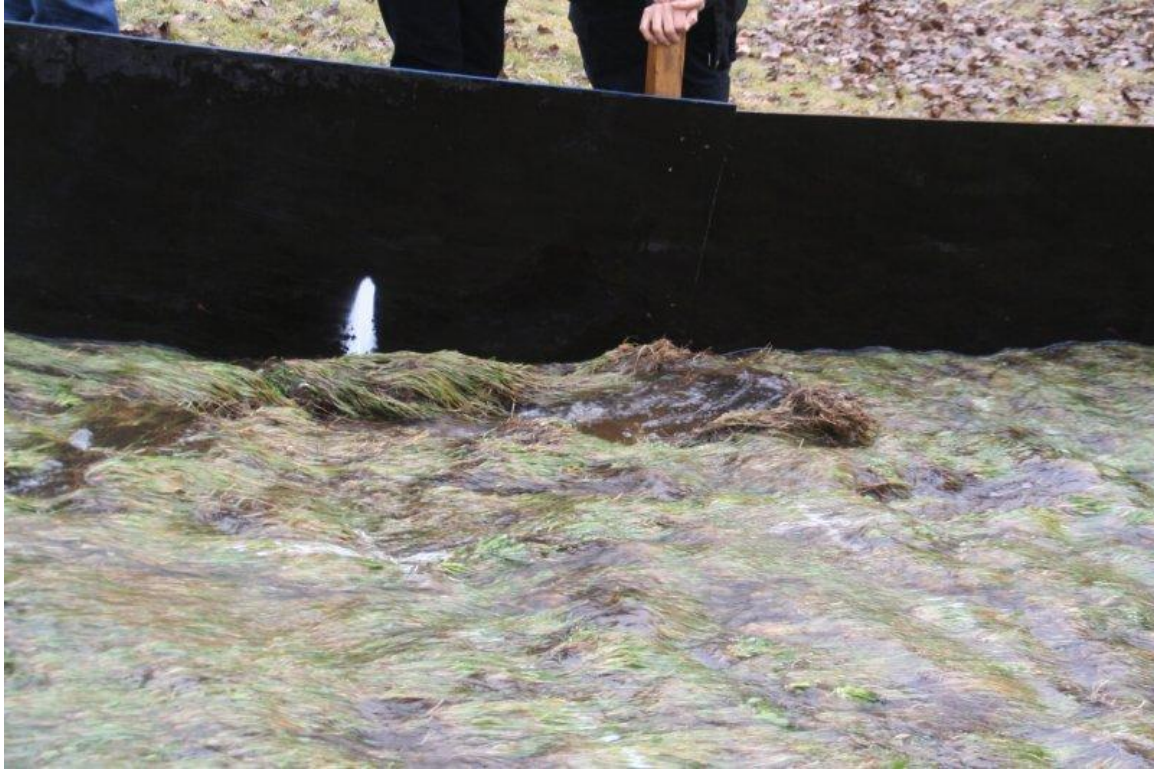
Foto B56. Vechtdijk. Rivierregime, proef 4; Eerste schade
