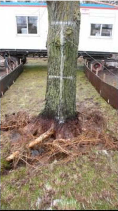
Figuur 8.1 Schade als gevolg van stroomconcentratie en turbulentie na grote overslagdebieten (Golfoverslagproeven Vechtdijk, 5½ uur 50 l/s per m)
