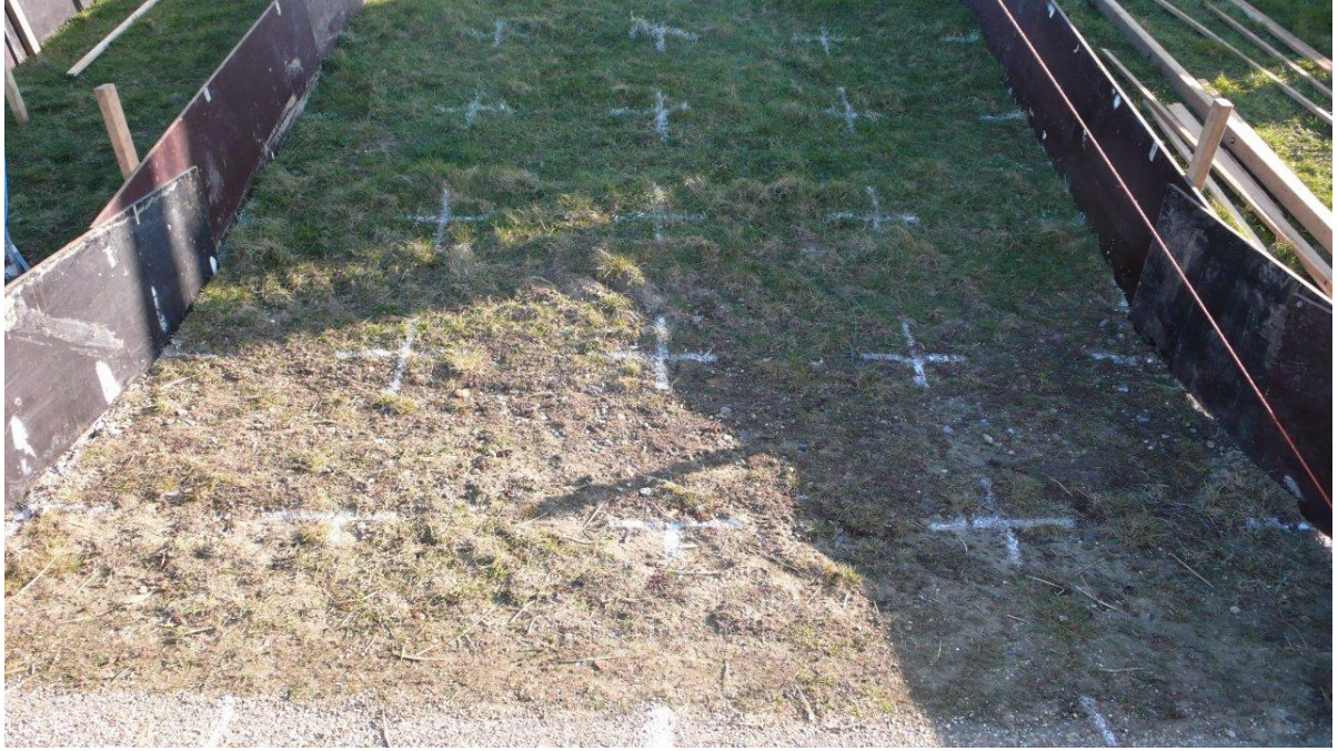
Figuur B102. Tholen, sectie A, oploop buitentalud. Vooraf.
