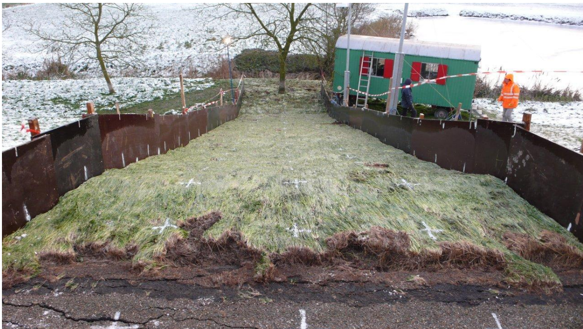
Figuur B66. Tielrode, België. Durmedijk. Na alle series. Geringe uitbreiding schade overgang asfaltkruin naar gras. Geen schade aan talud of boom.
