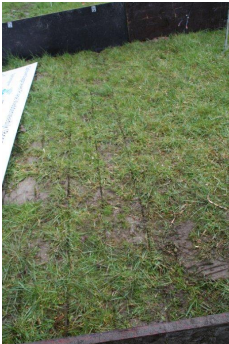
Foto B23. Kattendijke. Sectie 2. Initiële schade door mestinjecteur op benedentalud.
