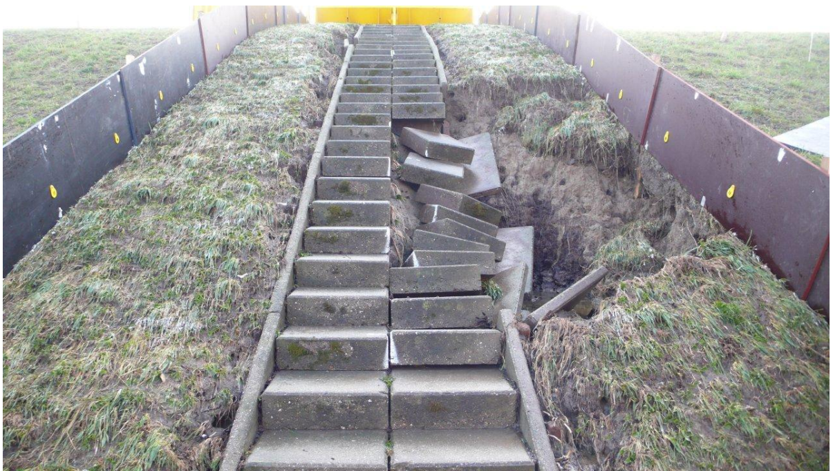
Figuur B83. Tholen. Sectie 2, trap. Bezweken trap.
