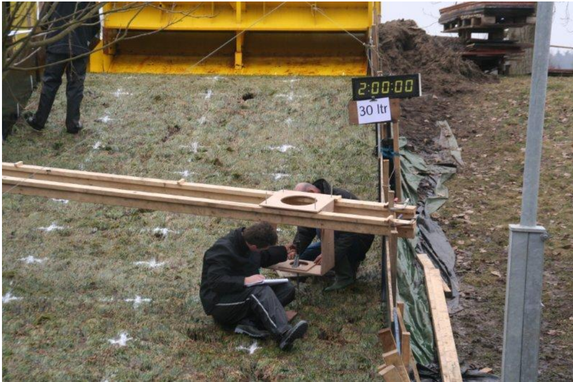
Foto B44. Vechtdijk. Zeeregime met boom, proef 2; Meerdere kale plekken talud.
