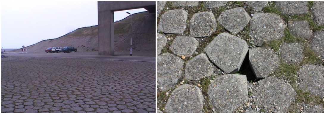
Afbeelding 3.5 Bekleding sluisplateau Roompotsluis
