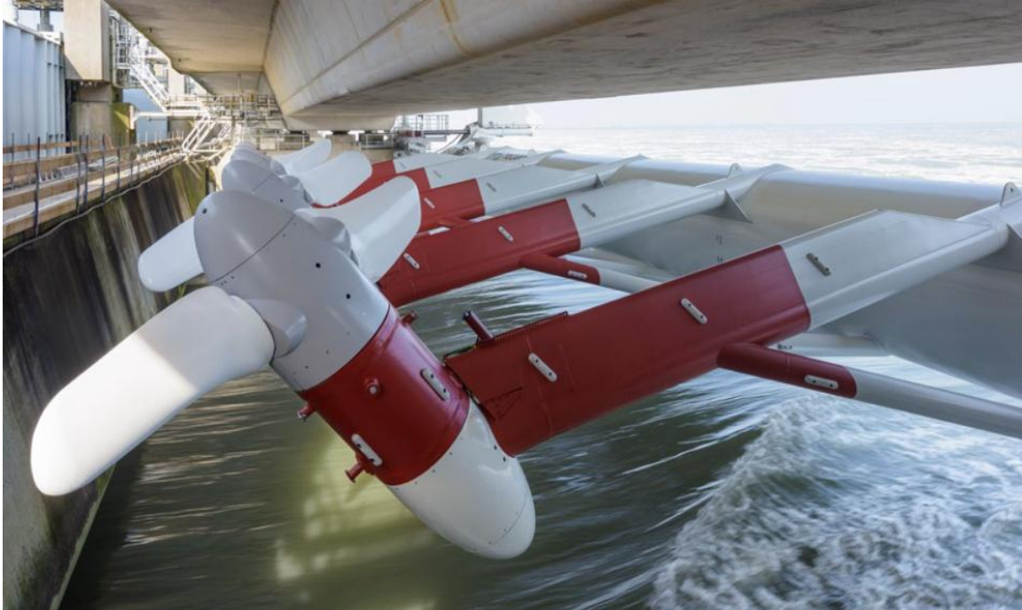
Afbeelding 7.2 Getijde energie turbines in de OSK
