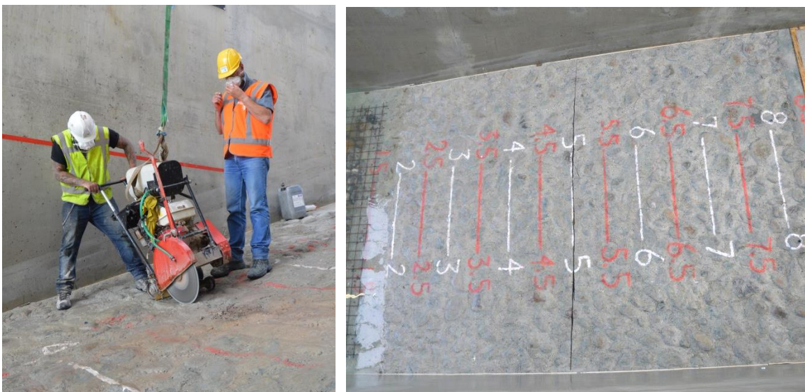
Figuur 6.7 Na proef N12 is een zaagsnede in de bekleding gemaakt bij lijn 5.
