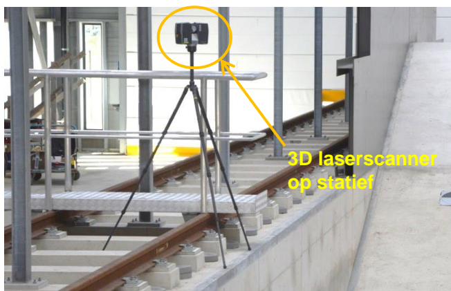
Figuur 4.2 Voor het inmeten van het taludoppervlak is gebruikgemaakt van een 3D laserscanner.
