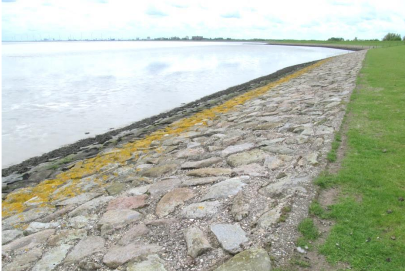
Figuur 2.2 Noorse steen, ingegoten met beton, ter plaatse van km 31,5 op de dijk Eemshaven - Delfzijl.
