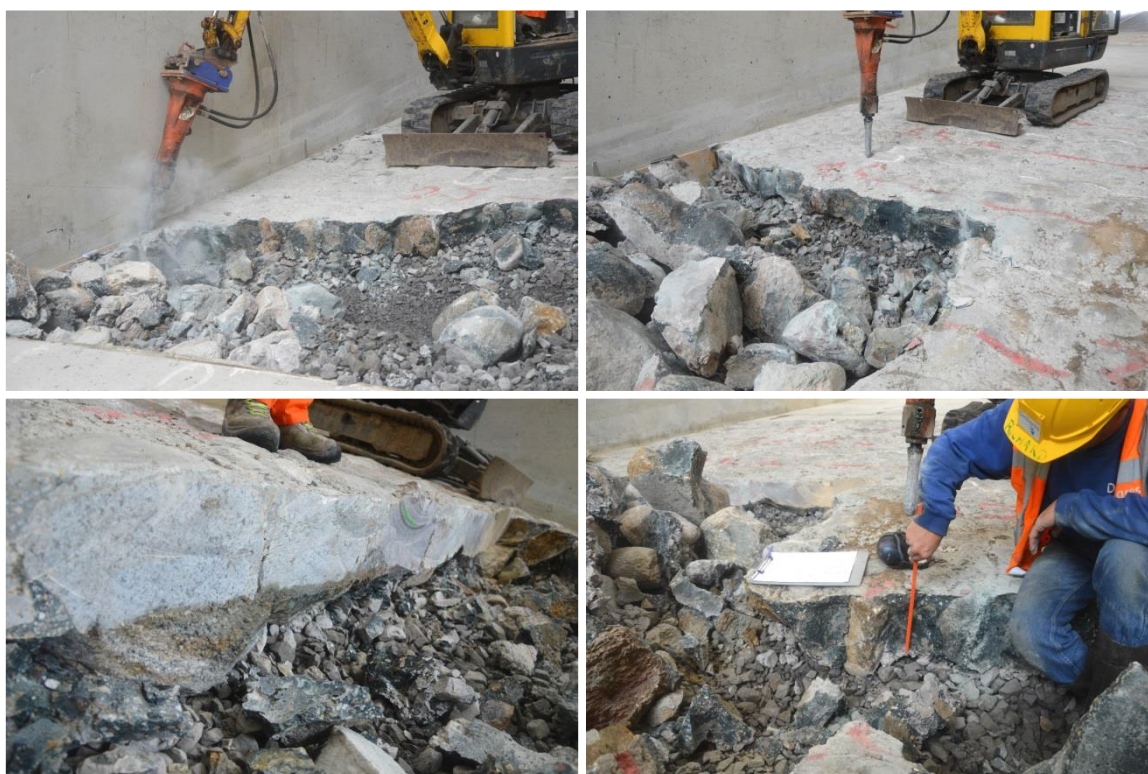
Figuur 3.10 Foto's van tijdens het uitbreken van de bekleding (links onder: ter plaatse van de zaagsnede, zie Figuur 6.7)
