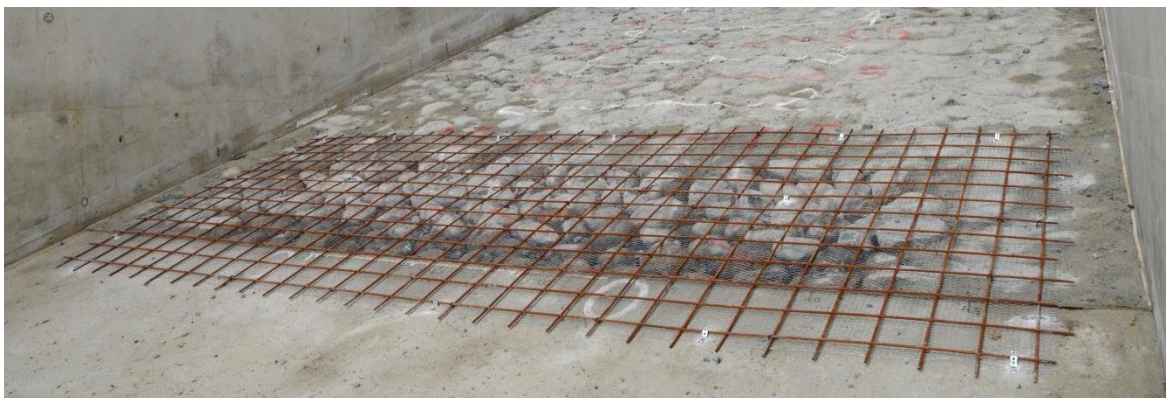
Figuur 6.6 De stenen zijn teruggeplaatst en het niet-ingegoten deel is afgedekt met kippengaas en een betonwapeningsnet om schade tijdens volgende proeven te voorkomen.
