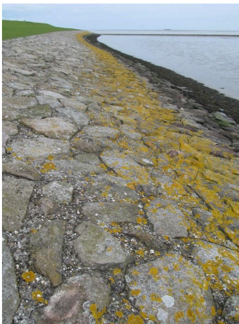
Figuur 9.1 Noorse steen op de dijk Eemshaven - Delfzijl (bij km 31,5)
