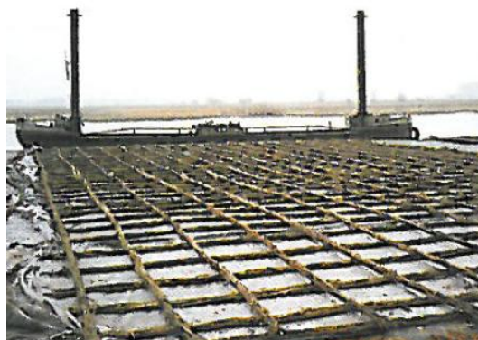
Figuur 3: Zinkstuk, een weefsel met een roosterwerk van wiepen [1]
