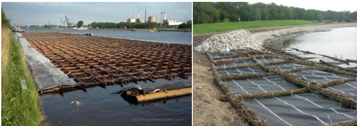
Figuur 6: links; verplaatsen zinkstuk, rechts; geotextiel met wiepenrooster [1]
