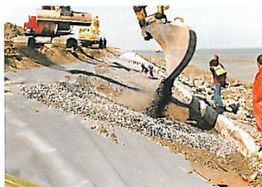
Figuur 4: Aanbrengen filterlaag op een vlies voor een dijkbekleding [1]
