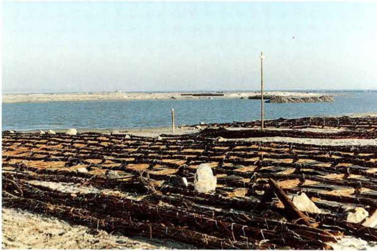
De aanleg van de Noordplaat.
