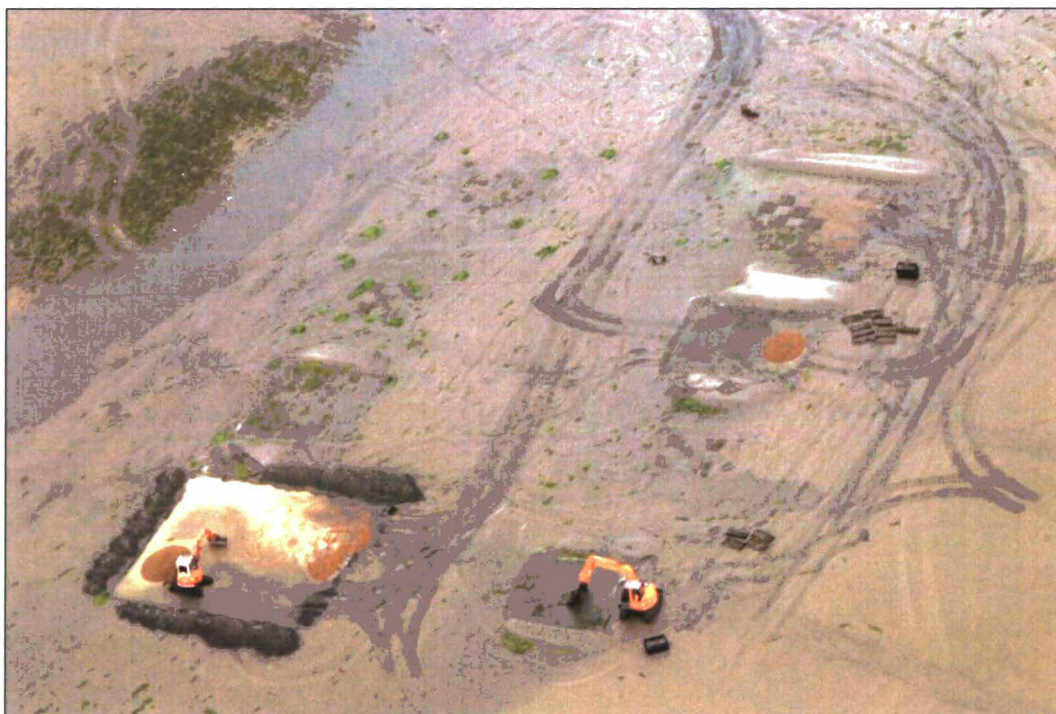
Foto 9 Luchtfoto van werkzaamheden op de Dortsman Noord
