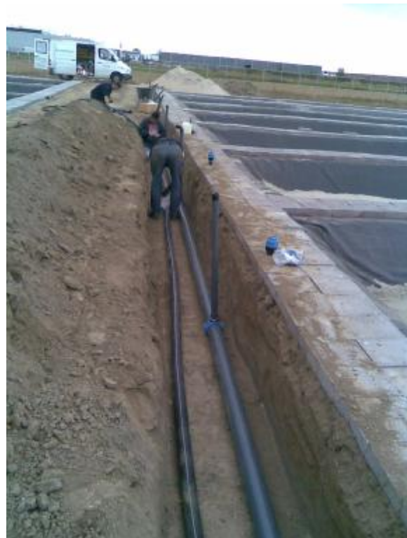
Aanleg leidingwerk bij schelpdiervijvers
