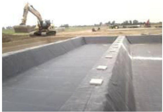
Aanleg vijvers bij de schelpdierpilot
