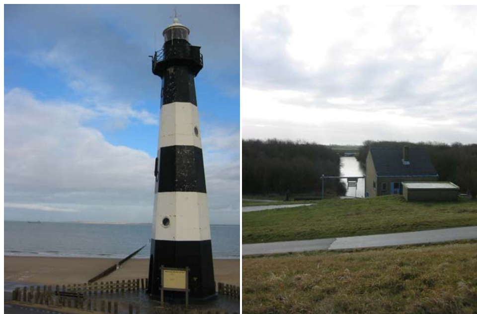
Vuurtoren en uitlaatwerk Nieuwsluis
