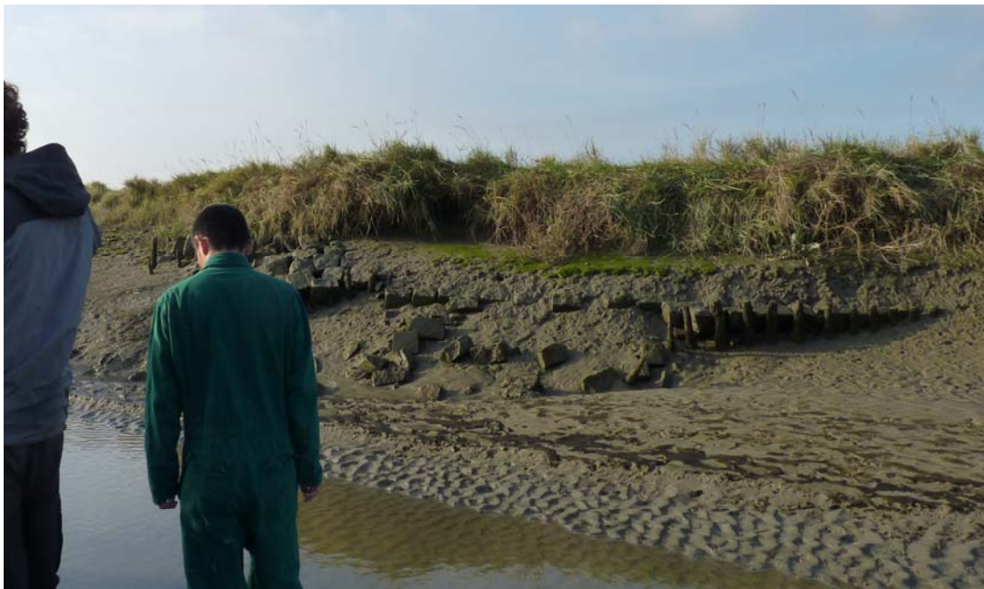
Figuur 6. Restant van de dam waarmee sedimentatie op het Land van Saeftinghe is bevorderd (Foto: Alma de Groot).
