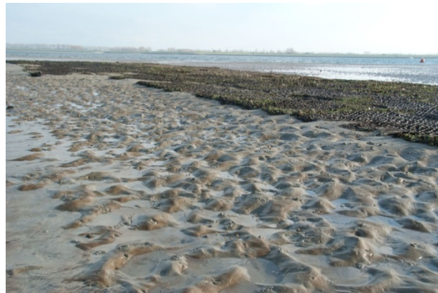
Figuur 19. Kunstmatige oesterriffen bij De Val (links) en Viane (rechts) in de Oosterschelde. Op de foto rechts is duidelijk sedimentatie te zien achter het rif.
