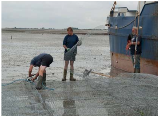
Figuur 18. Aanleg van kunstmatige oesterriffen in de Oosterschelde in het kader van Building with Nature.
