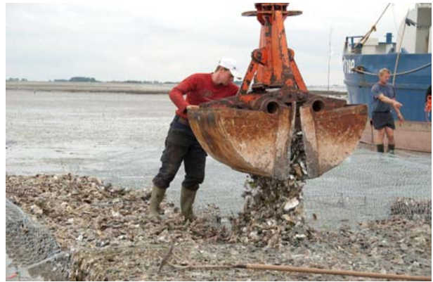
Figuur 18. Aanleg van kunstmatige oesterriffen in de Oosterschelde in het kader van Building with Nature.
