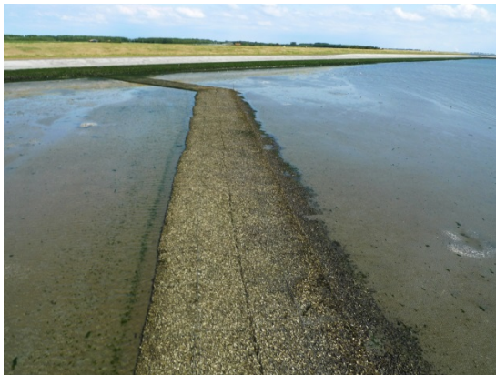
Figuur 19. Kunstmatige oesterriffen bij De Val (links) en Viane (rechts) in de Oosterschelde. Op de foto rechts is duidelijk sedimentatie te zien achter het rif.
