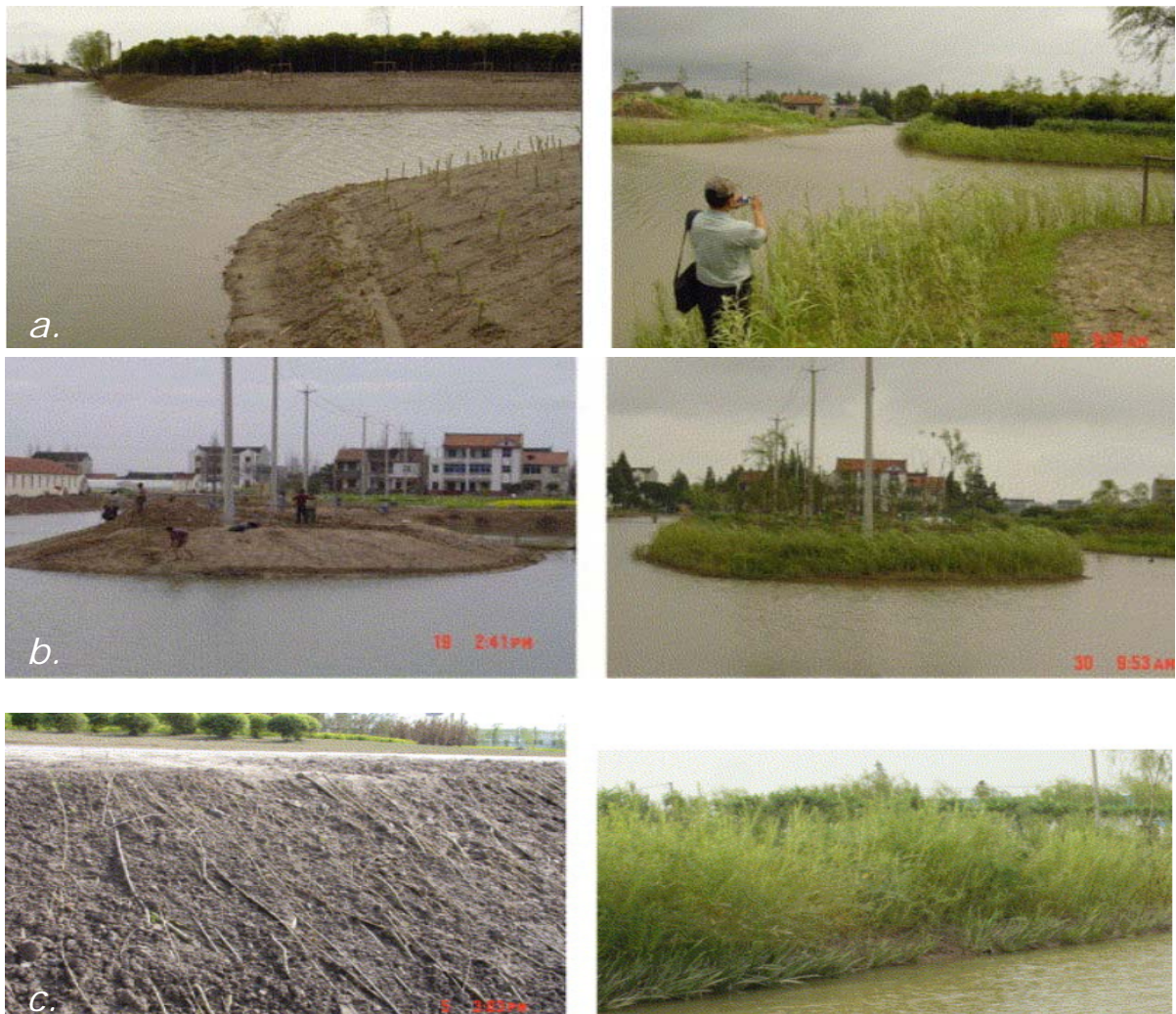
Figuur 12. Ervaring met gebruik van levende wilgen takken in China met gebruik van verschillende beplantingstechnieken. a. rechtop planten van wilgen taken b. bevestigen van gebundelde takkenbosjes op de oever c. gebruik van een wilgenhouten kreupelhouten laag gedeeltelijk bedekt met aarde (bron: (Li et al. 2006)).
