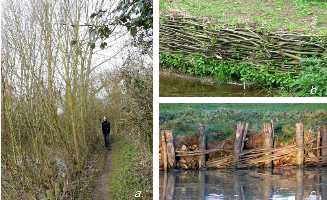
Figuur 11. Ervaring met gebruik van levende wilgentenen schermen in het Verenigd Koninkrijk volgens een studie van Anstead en Boar (2010). a. Succesvolle toepassing van een levend wilgenscherm (15 jaar oud) b. recentelijk aangelegd wilgenscherm met groei van eerste uitlopers. c. Uit elkaar gevallen scherm van afgestorven takken twee jaar na aanleg.
