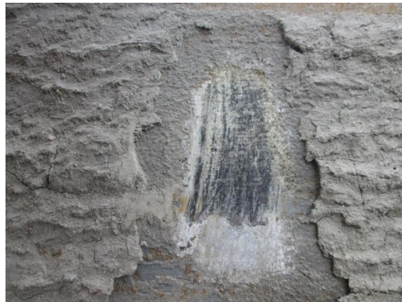
Foto van het oppervlak op 18,5 m -mv, na verwijderen van het aanhechtende grondlaagje.
