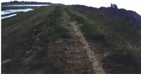
Afbeelding 5: Dijk ter hoogte van Ouwerkerkse inlaag.
