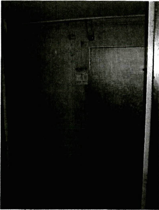
Foto 2155: aanzicht koelcel met toegangsdeur, paviljoen
