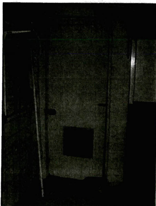
Foto 2146: bron 2, plaat op deur voormalige c.v.-ruimte paviljoen
