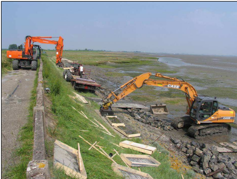
Figuur 7 Twee kranen in gebruik bij rooien van plaggen op donorlocatie
