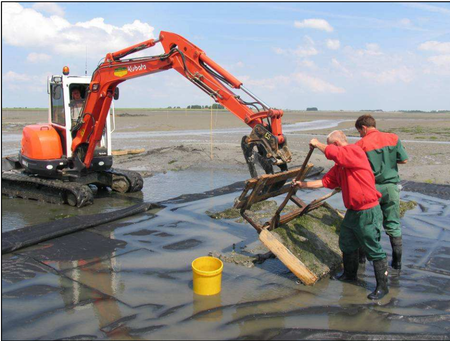
Foto 3 Krabbenkreek: Leggen van plaggen in een plot waarin een net is aangebracht
