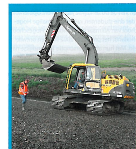
In de Zeelandse Bathpolder is 12.000 m 2 Elastocoast aangebracht (2009) ter vervanging van Haringmanblokken (onder in de foto). Het verschil in golfloopreducerende werking is goed zichtbaar in de veekrand (de rand met rommel die het hoogwater achterlaat).
