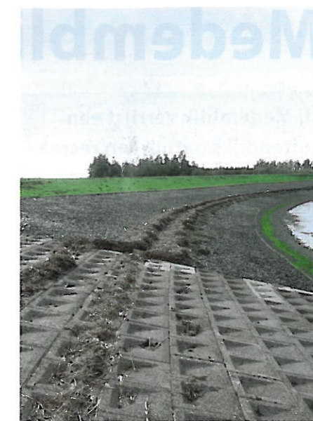
In de Zeelandse Bathpolder is 12.000 m 2 Elastocoast aangebracht (2009) ter vervanging van Haringmanblokken (onder in de foto). Het verschil in golfloopreducerende werking is goed zichtbaar in de veekrand (de rand met rommel die het hoogwater achterlaat).
