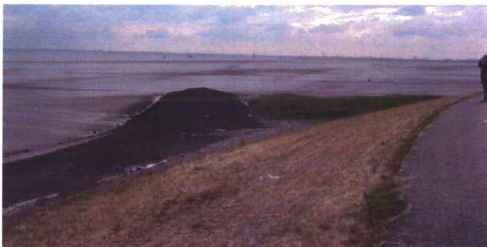
Figuur 24: Huidige situatie verborgen bekleding Baalhoek
