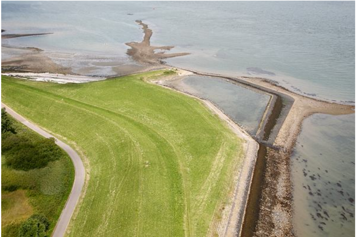
Getijdenpoeltje, ingeklemd tussen huidige primaire waterkering en een voormalige dijk.
