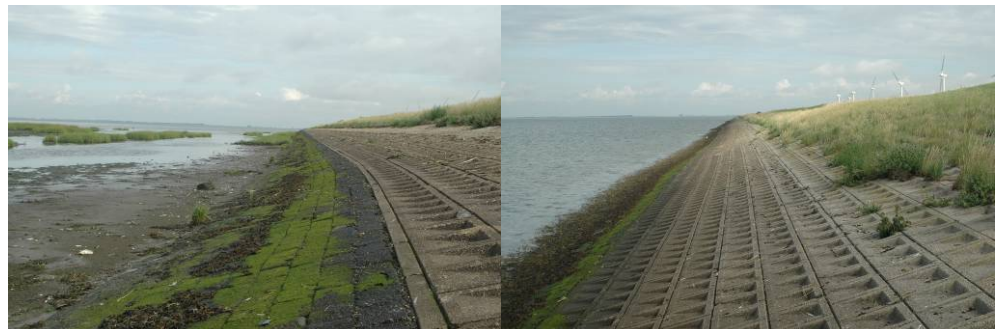
Foto 2.1: Koperslakblokken (ondertafel) en haringmanblokken (boventafel) op de Oesterdam-Zuid.
