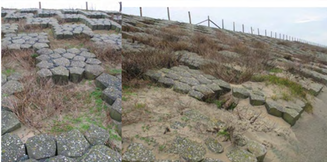
Afbeelding 8.3: Verstuivingsgradient met weinig overstuiving aan de bovenkant (links) en snel toenemend naar onder toe (rechts)
