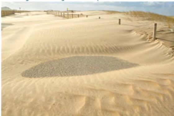
Afbeelding 8.6: Ondergestoven fietspad in de Hondsbossche Duinen (foto: HHNK)
