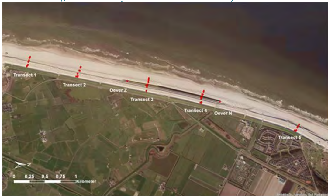
Afbeelding 2.5: Ligging van de vijf transecten en permanente proefvlakken (rode stippen). De nummers van de proefvlakken lopen steeds op, van het strand richting de oude Hondsbossche en Pettemer zeedijk.
