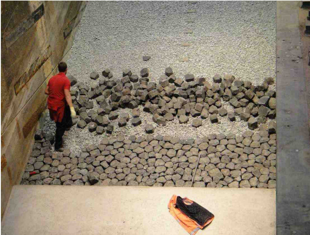
a) Aanbrengen basalt (1)
