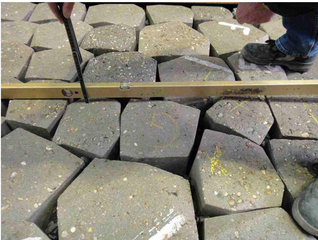
b) Schade na proef 8 (1)
