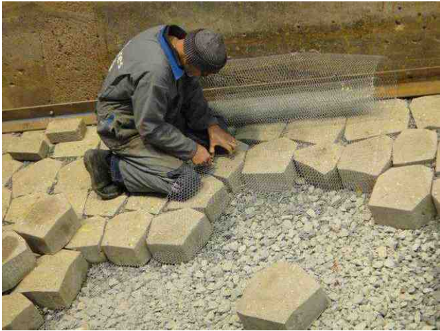
a) Herstel na proef 6 (aanbrengen gaas)
