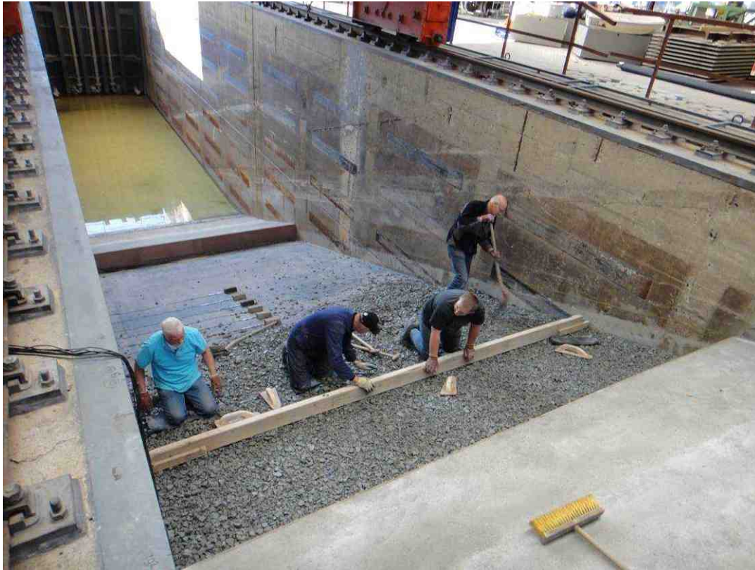
a) Aanbrengen onderste filterlaag (1)
