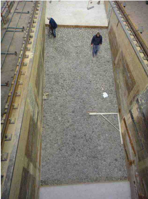
a) Basaltlaag na inwassen
