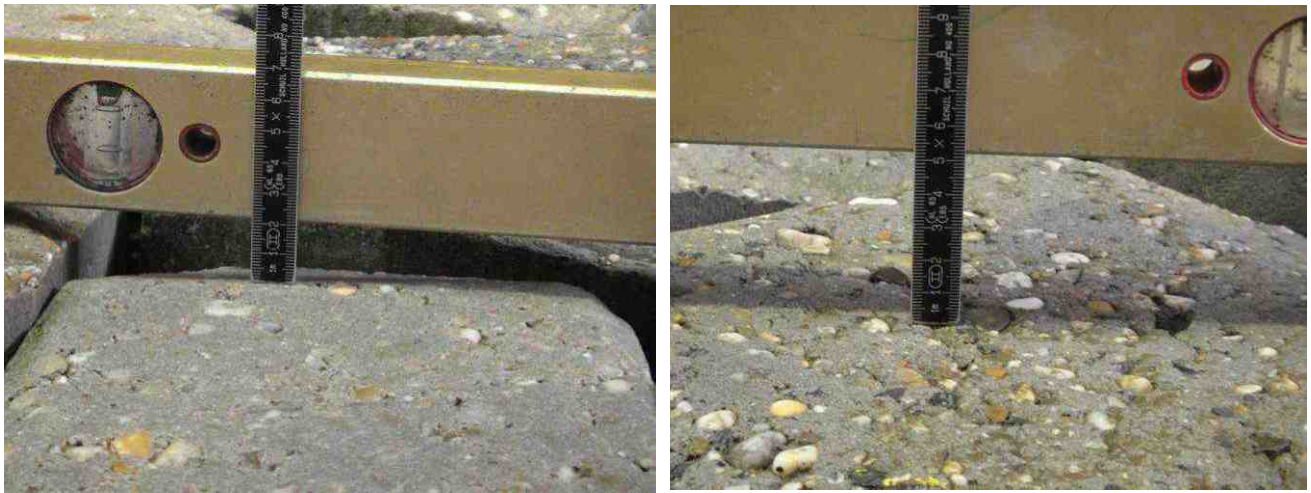
a) Schade na proef 8 (2)
