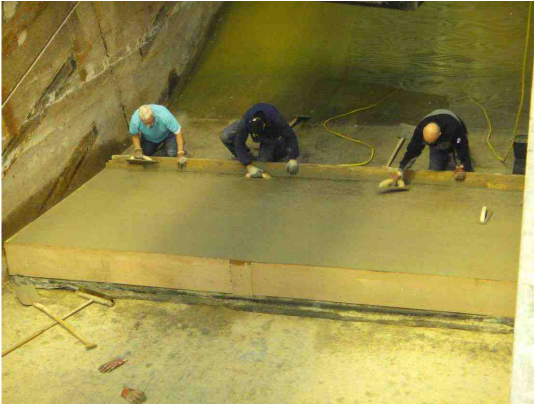
a) Constructie overgang betonnen sectie (1)
