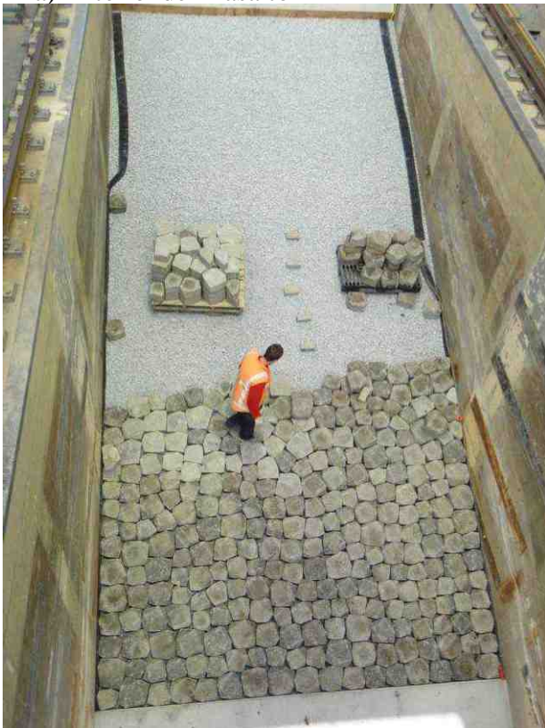
b) Aanbrengen Basalton
