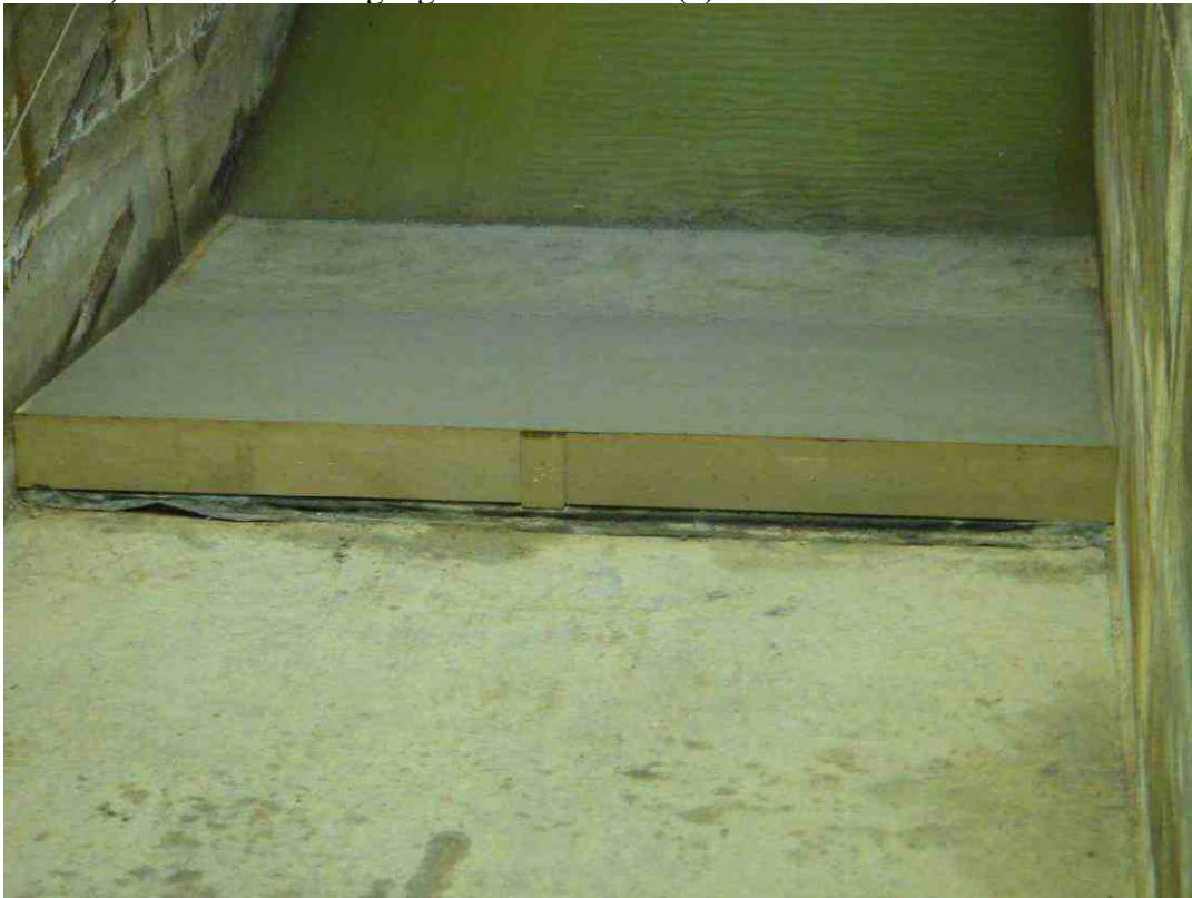
b) Constructie overgang betonnen sectie (2)
