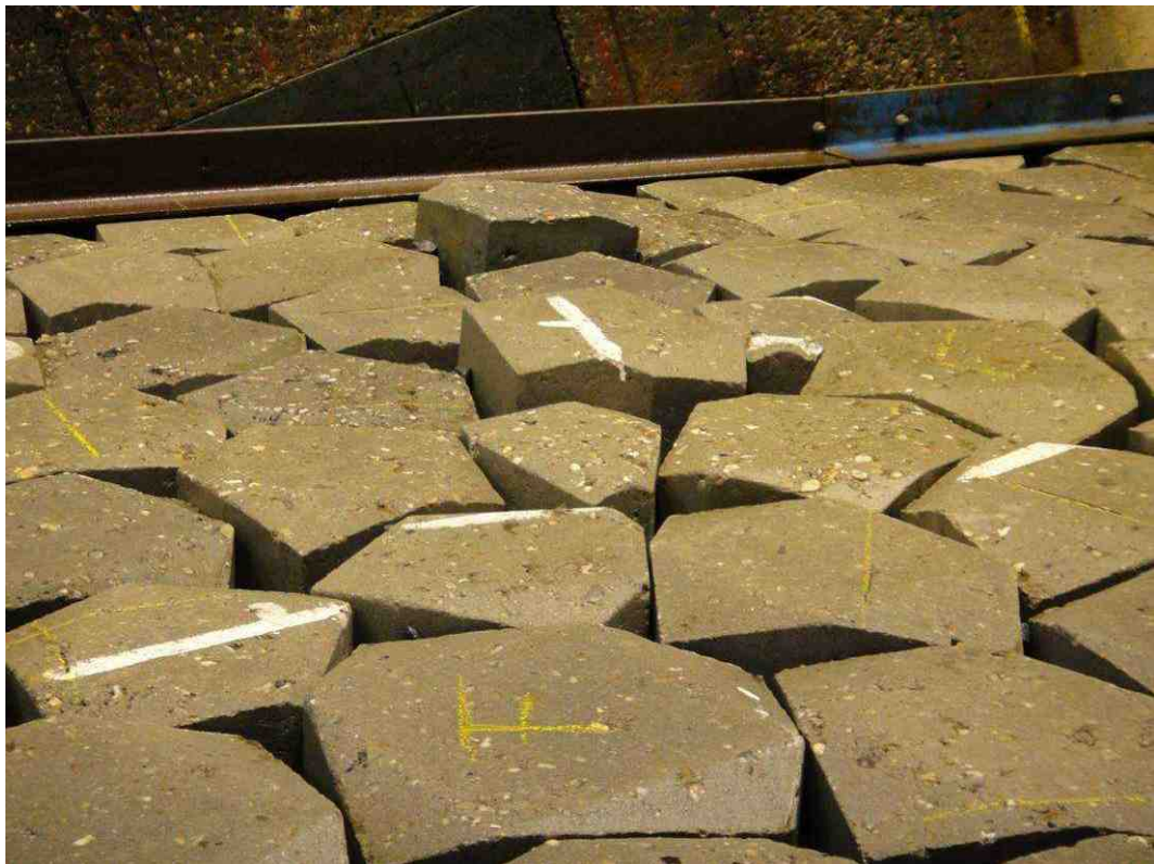
b) Schade na proef 7 (1)
