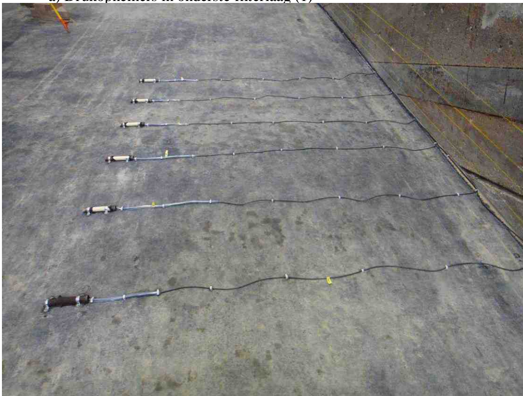
b) Drukopnemers in onderste filterlaag (2)
