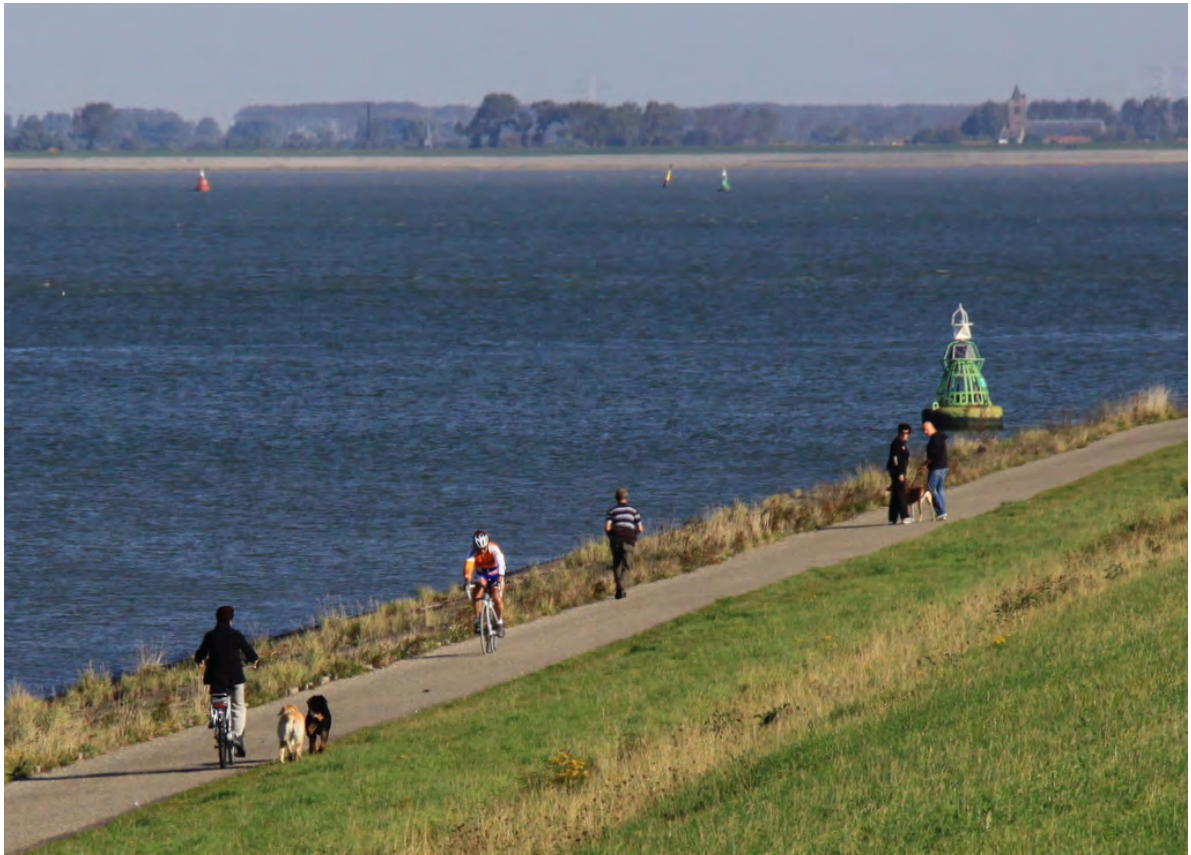
De aanleg van verharde onderhoudswegen heeft enkele honderden kilometers aantrekkelijk fietspad opgeleverd. Zeedijk Margarethapolder, Terneuzen, 3 oktober 2010 (Peter Meininger).
