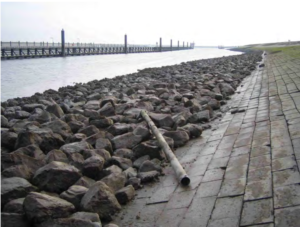
Kreukelbermen worden sinds de jaren 1990 hoger aangelegd. Nabij Hansweert, 7 november 2008 (Martien Meijer; Bureau Waardenburg).
