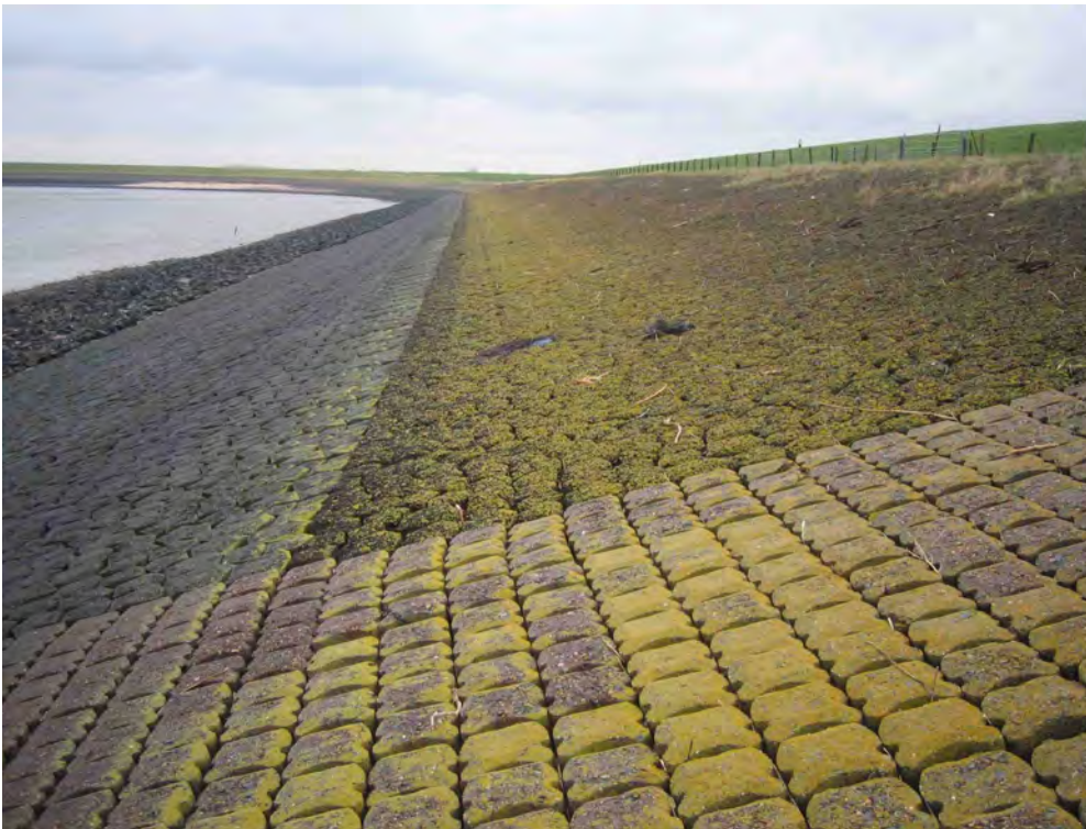
Korstmossen op hydroblocks (voorgond) en op ecozuilen (basalton met eco-toplaag van lavasteen). Ellewoutsdijkpolder, 19 november 2008 (Martien Meijer; Bureau Waardenburg).
