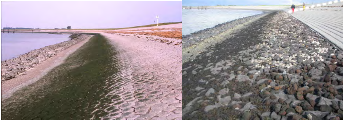
Vergelijking dijkvak Hansweert (oostzijde) 27 juli 1990 (links) met 2 oktober 2008 (rechts). Op de nieuwe glooiing is onder andere lavasteen nagestrooid (Martien Meijer; Bureau Waardenburg).
