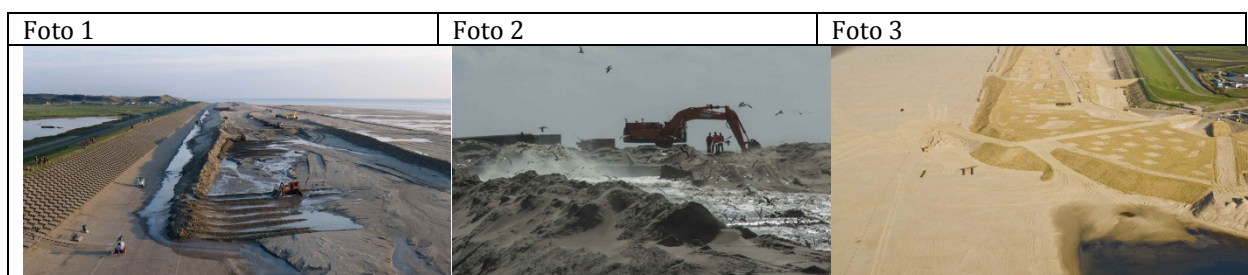
Figuur 4-1: Impressiefoto's werkzaamheden aanleg kustversterking HPZ, Fotos 1 en 2 zijn ergens medio augustus 2014 gemaakt. Foto 3 ergens in de winter (dec '14/jan '15), voor het openen/graven van de strandlagune. (Bron: website rijkswaterstaat 9 )
