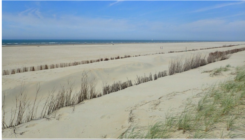
Foto C-1: Illustratie van wilgenschermen en invang aan de voet van het duin van de kustversterking HPZ. (Foto: Alma de Groot).
