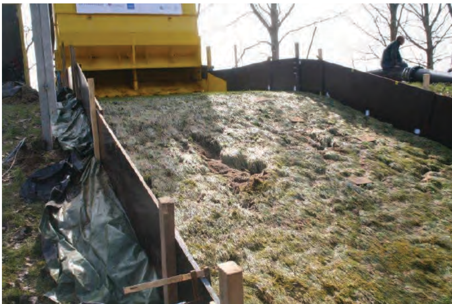
Figuur 60 Overslagproef vechtdijk - Eerste schade (Meer, 2012)
