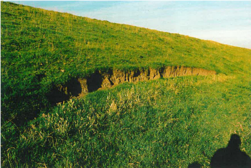
Figuur 9.1 Afschuiving binnentalud Zuidelijk Voorne Putten (bron Deltares)
